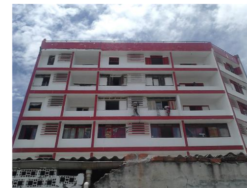
Figura 9: Vista externa do Edifício Mauá
