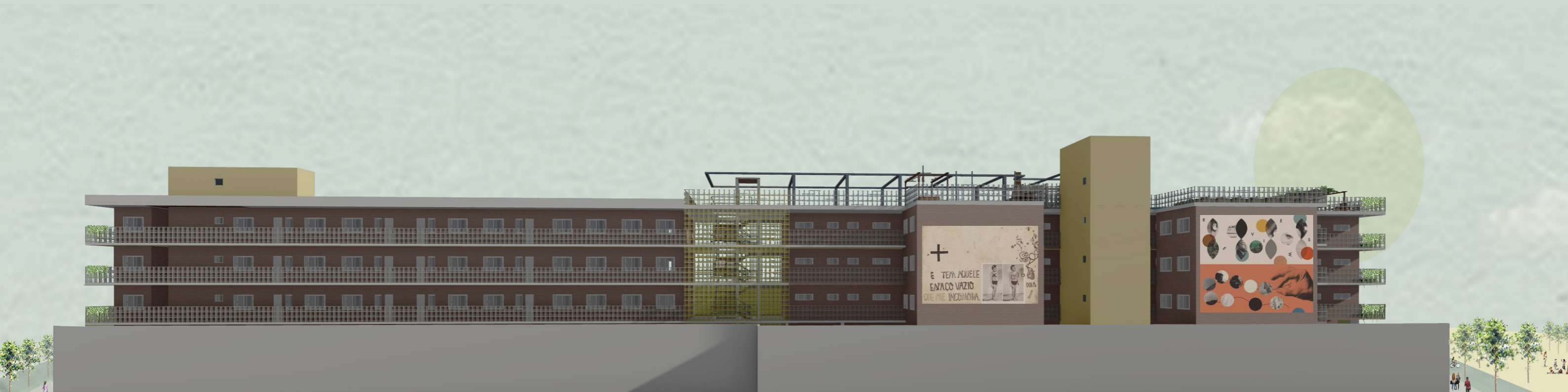
Figura 87: Fachada voltada para Rua Dr. João Moreira Fonte: Autora, 2020
