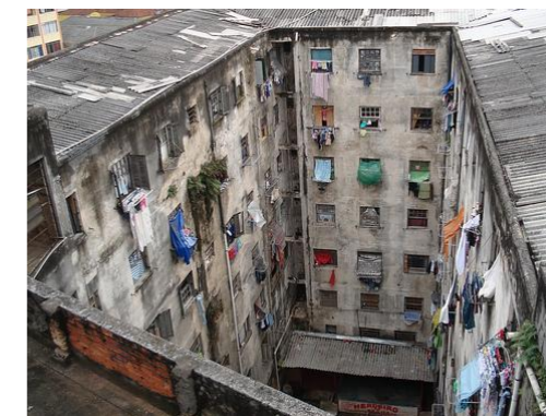
Figura 10: Vista interna do Edifício Mauá
