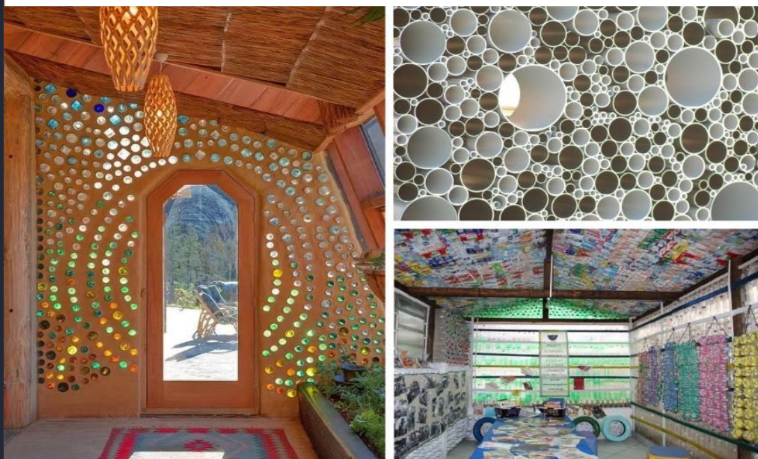
Figura 16 - Uso de garrafas de vidro, garrafas pet e canos de PVC como elementos de vedação, esquadria e decoração
