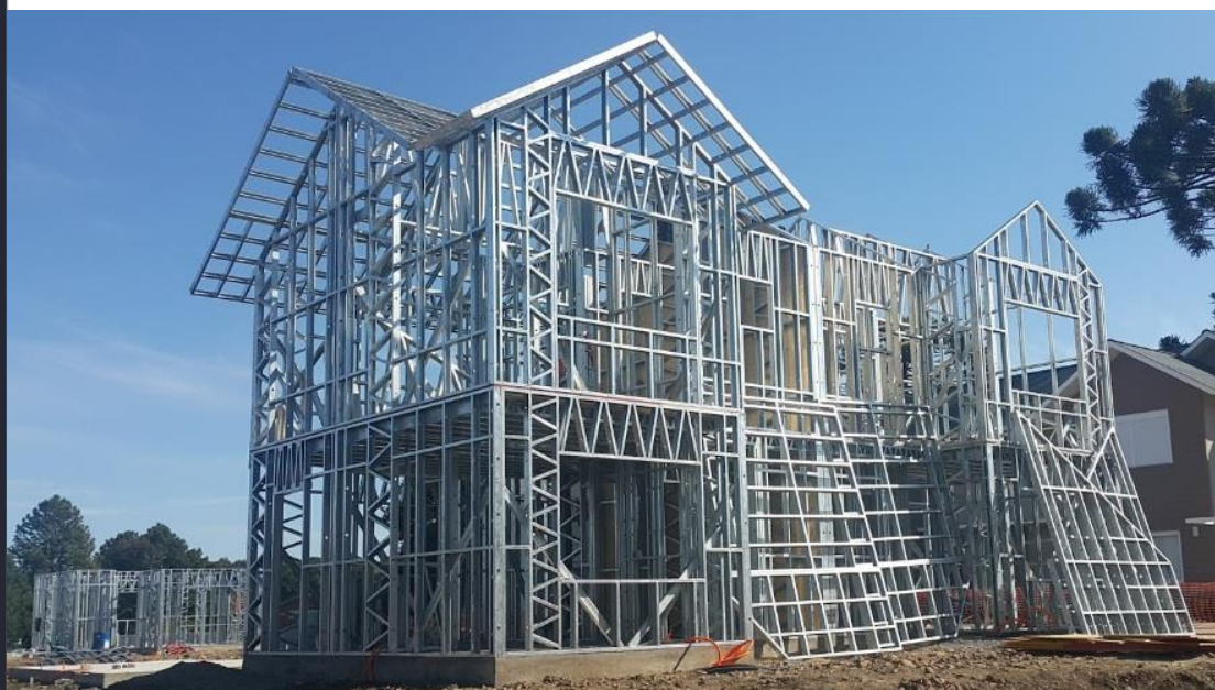
Figura 14 - Estrutura de light steel frame
