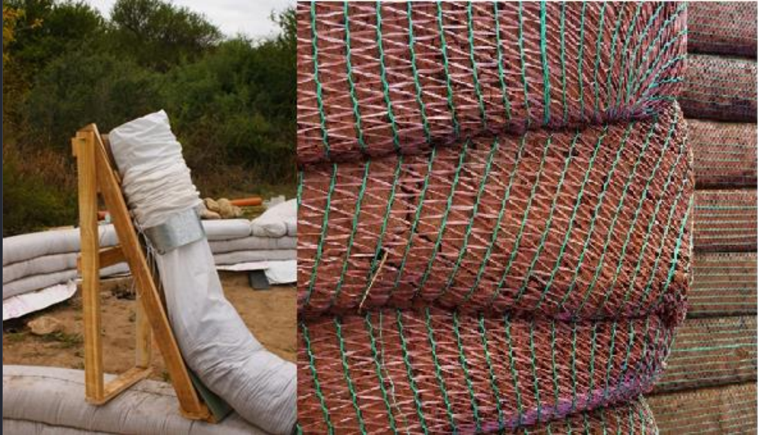
Figura 13 - a - Processo construtivo com super adobe; b - processo construtivo com hiperadobe
