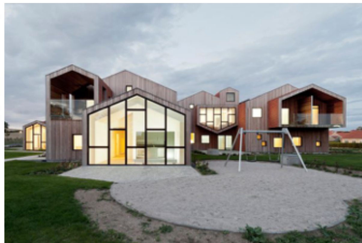
Imagem 11 - Vista Fachada Sul
