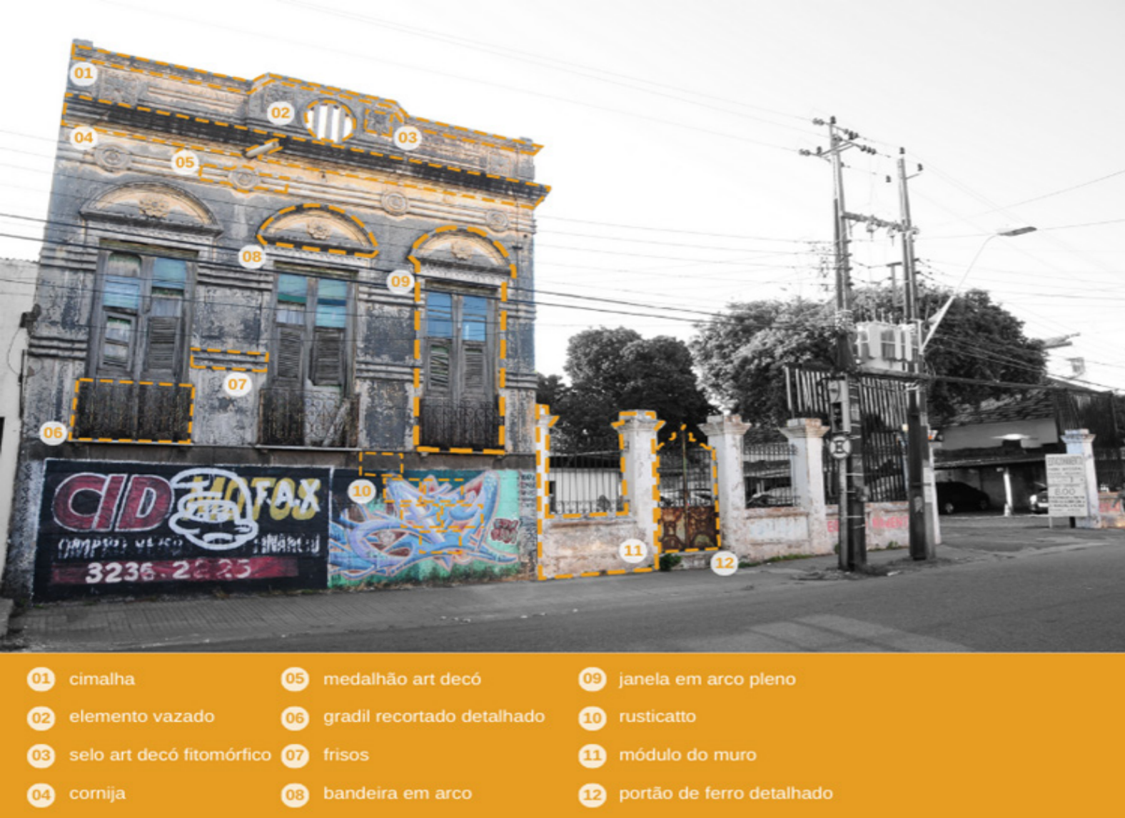
FIG.45 Fachada frontal Fonte: Secultfor, modificado pela autora
