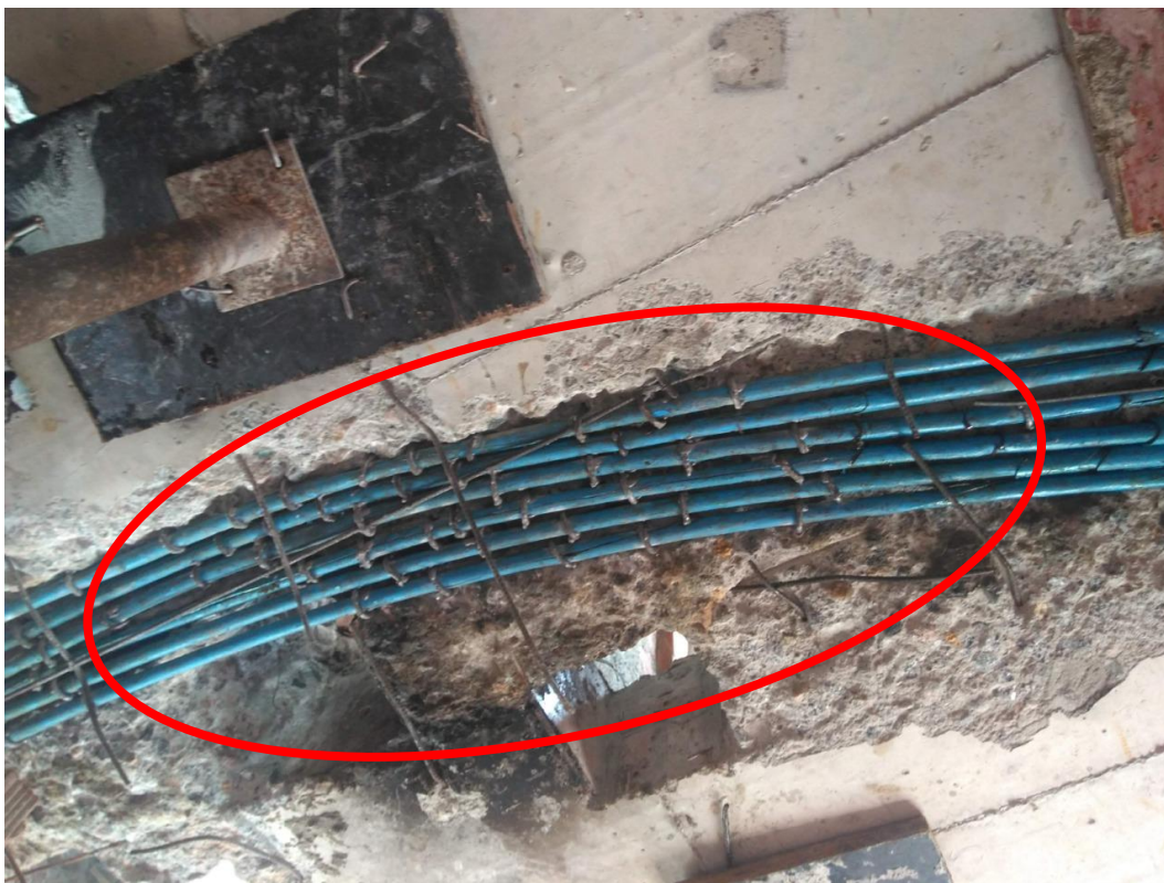
Figura 35 – Processo de grampeamento de cordoalha na estrutura
