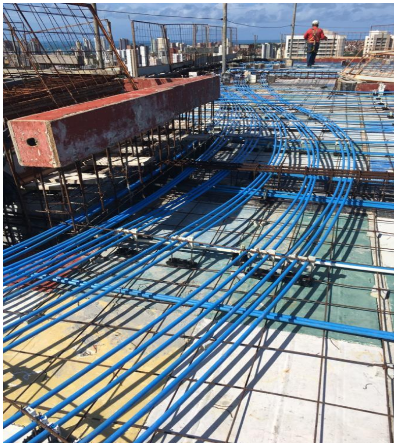
Figura 12 – Curvatura de protensão não aderente
