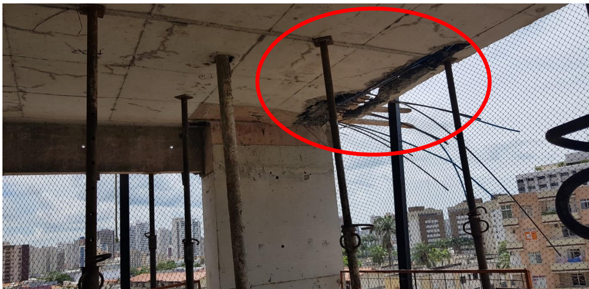
Figura 24 – Escoramento imediato da área afetada
