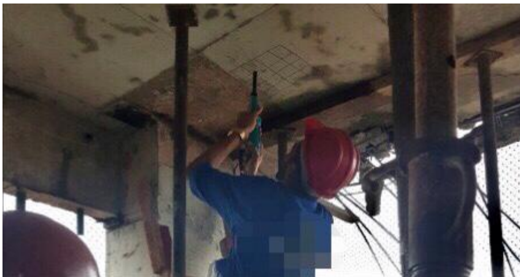
Figura 30 – Ensaio de esclerometria realizado em torno do local afetado
