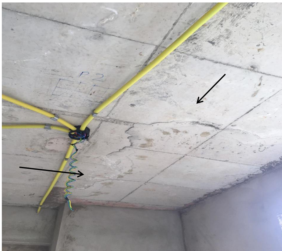
Figura 31 – Resultado final após os processos de reparo e reforço do local do rompimento da cordoalha
