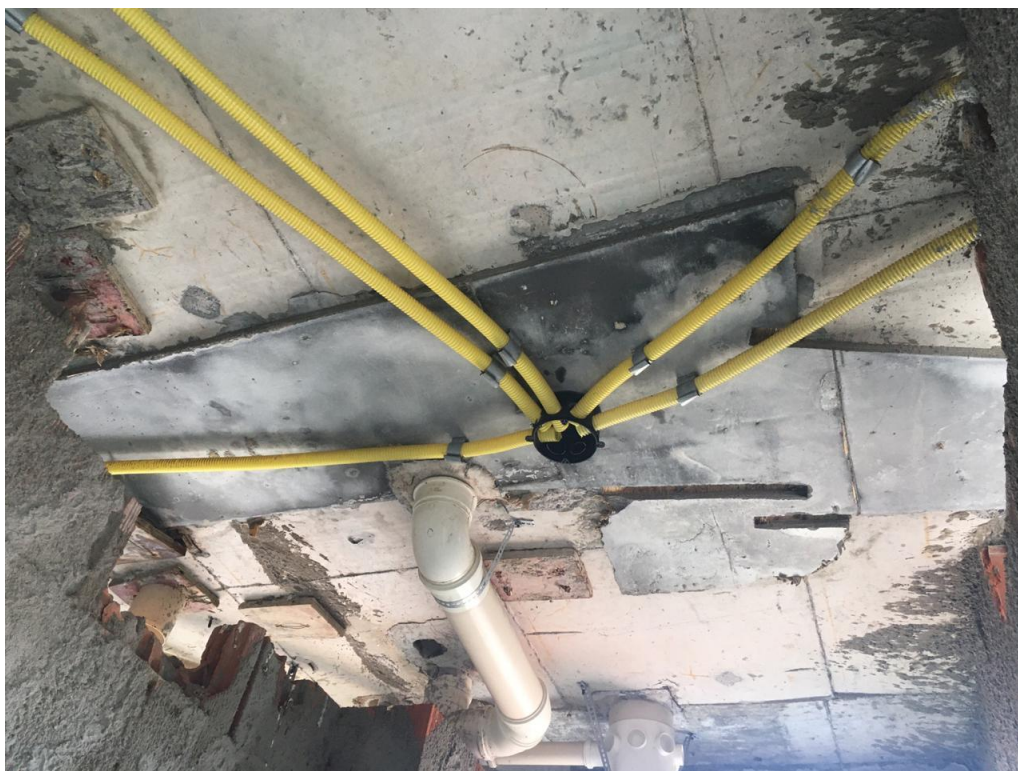
Figura 32 – Resultado final do reparo realizado para corrigir o deslocamento da faixa de cabos
