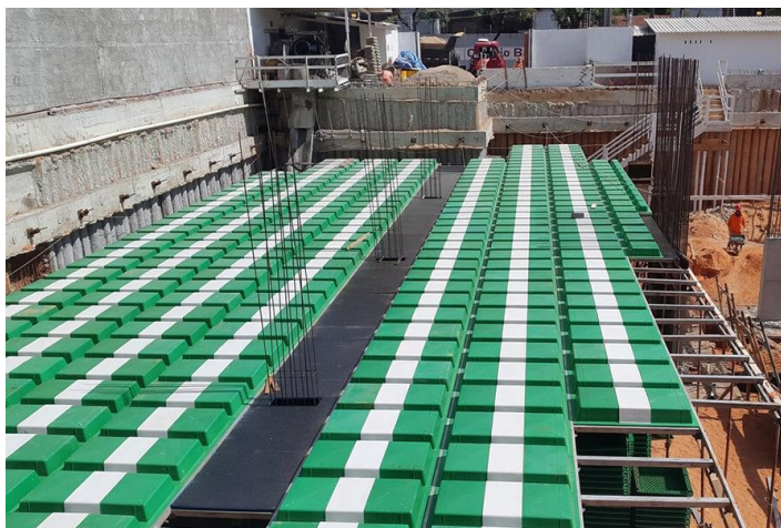
Figura 5 – Fôrmas plásticas de laje nervurada unidirecional em concreto armado
