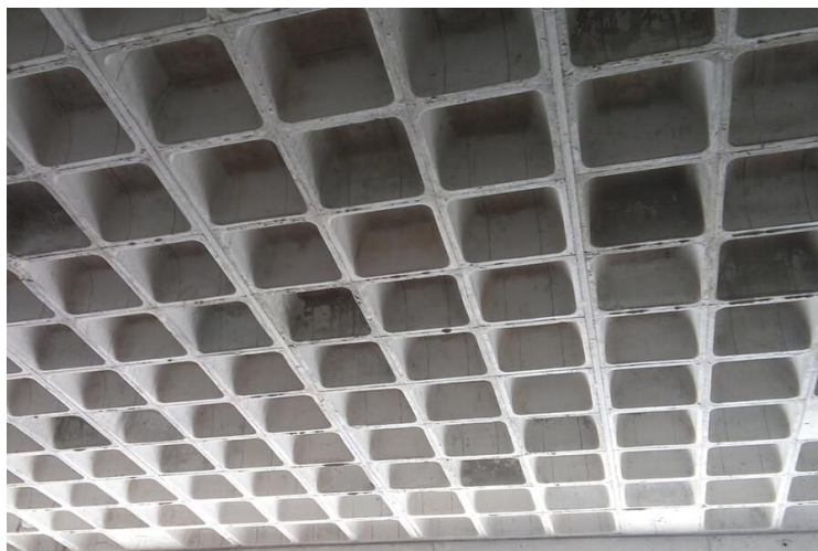
Figura 4 – Laje nervurada bidirecional em concreto armado
