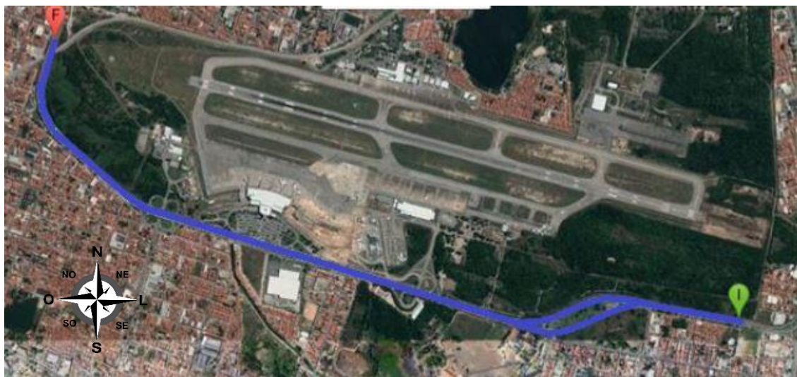
Figura 18 – Trecho com extensão de 4,1 km
