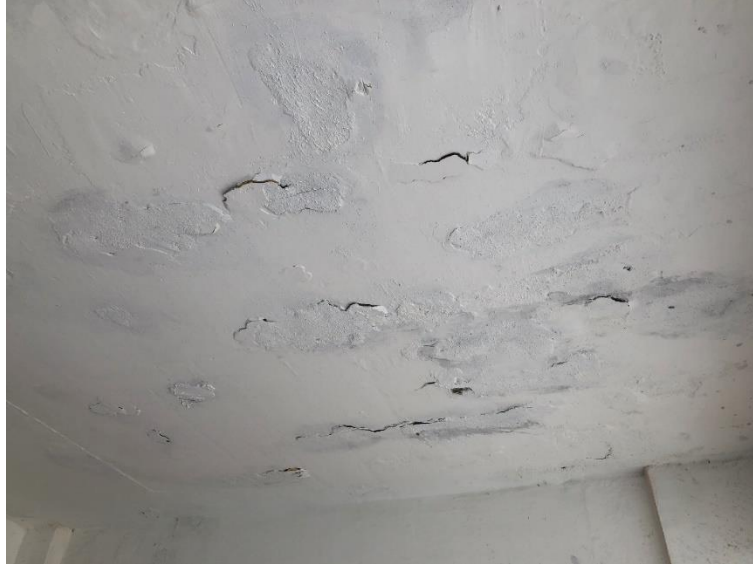
Figura 27 - Formação de bolhas devido infiltração
