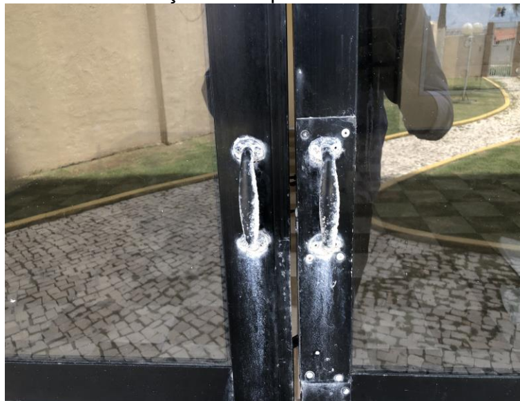
Figura 28 - Eflorescência em maçaneta de porta
