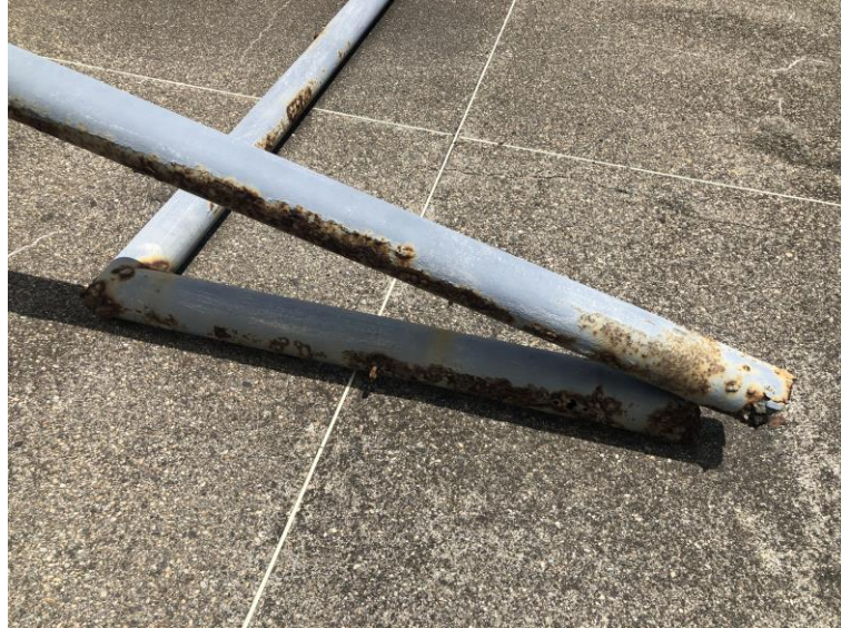
Figura 30 - Corrosão em trave de futebol
