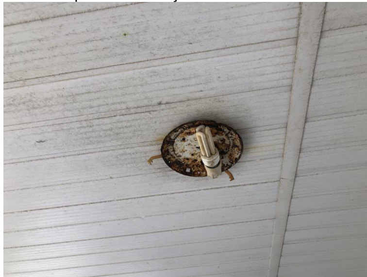
Figura 31 - Corrosão em spot de iluminação
