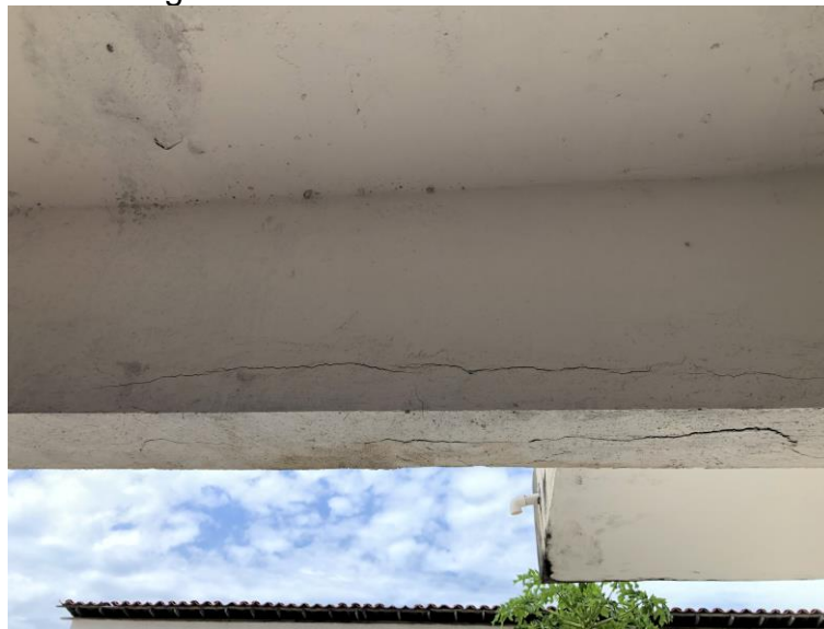
Figura 21 - Fissuras em viga
