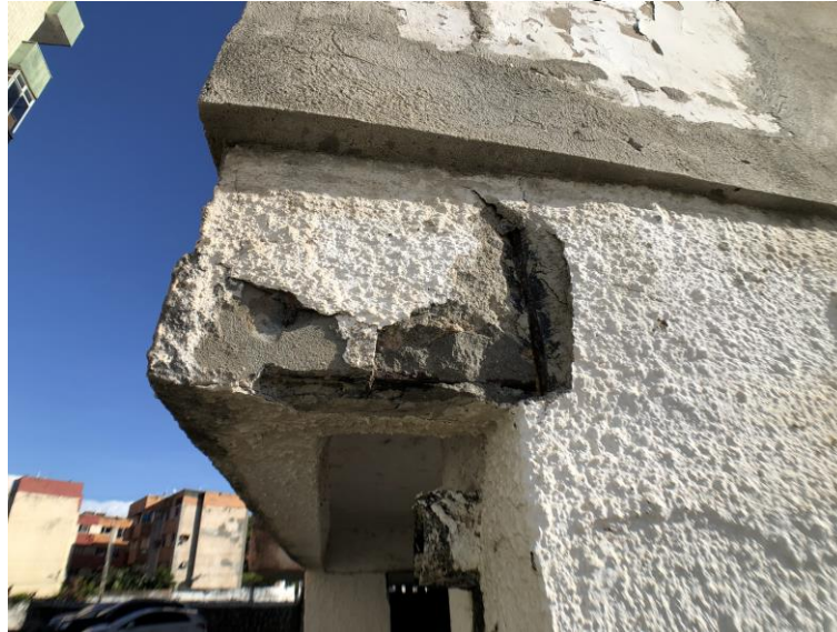
Figura 33 - Corrosão em armadura de encontro de viga com pilar
