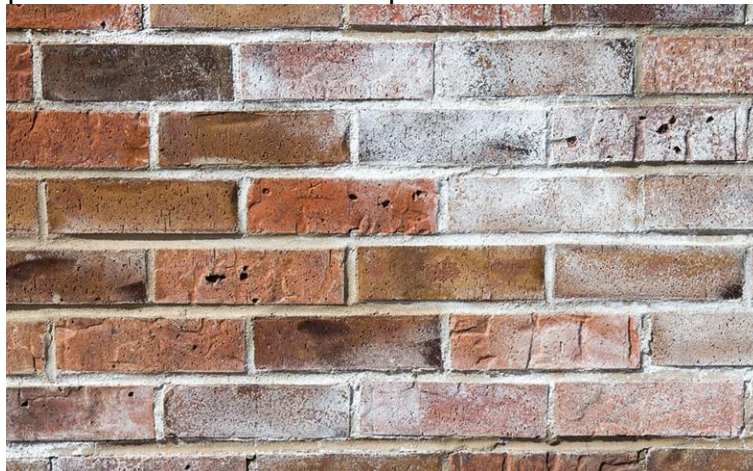
Figura 8 - Exemplo de eflorescência em superfície de revestimento cerâmico
