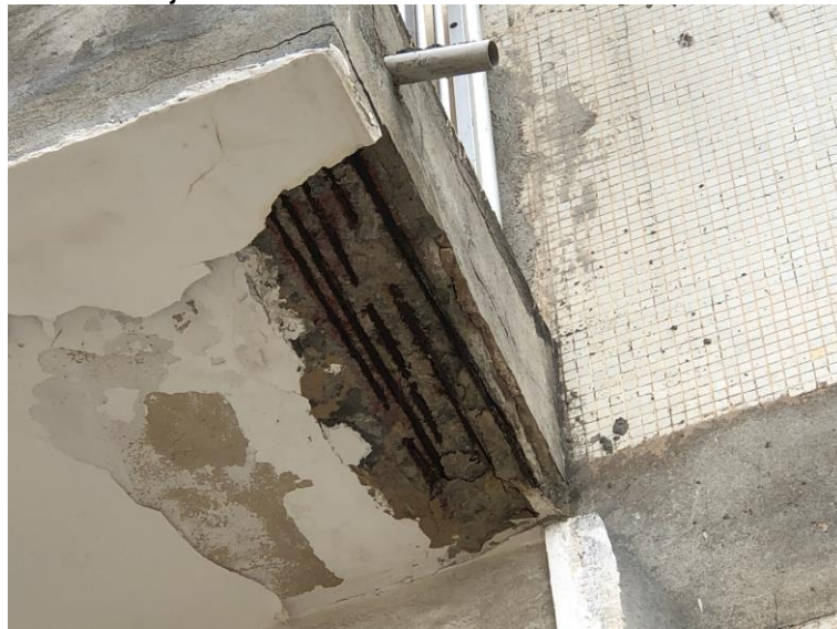
Figura 35 - Corrosão na laje de uma varanda
