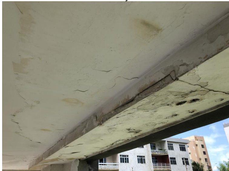
Figura 26 - Laje com manchas devido infiltrações
