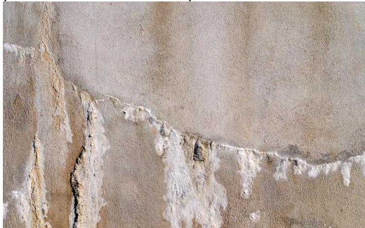
Figura 7 - Exemplo de eflorescência em superfície de alvenaria rebocada
