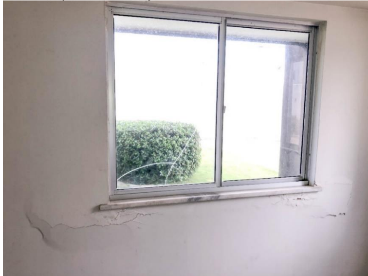
Figura 22 - Fissuras em parede com janela
