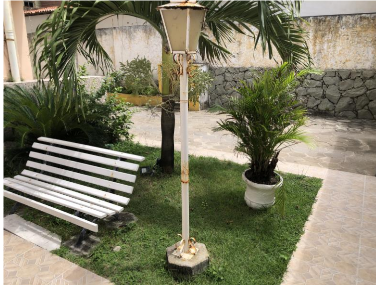
Figura 32 - Corrosão em poste de iluminação
