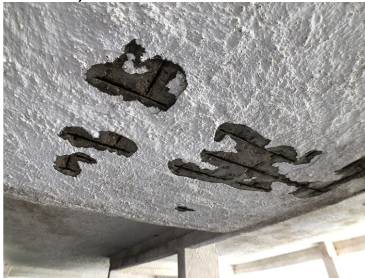
Figura 34 - Corrosão em laje
