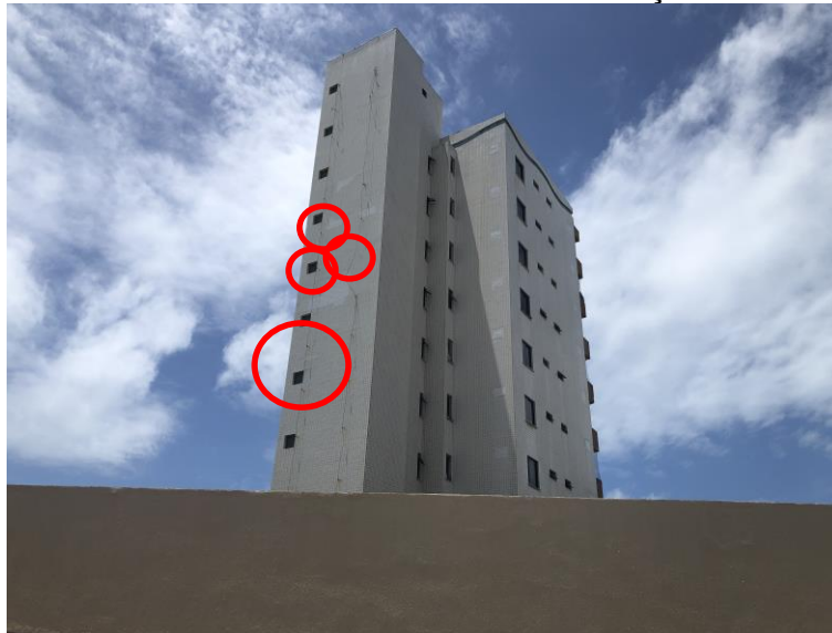
Figura 24 - Fachada de edifício com cerâmicas de coloração diferentes
