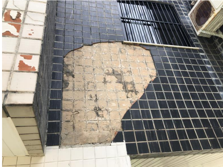
Figura 25 - Fachada com destacamento de placas cerâmicas
