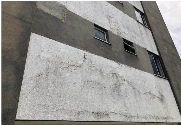
Figura 20 - Fissuras em fachada
