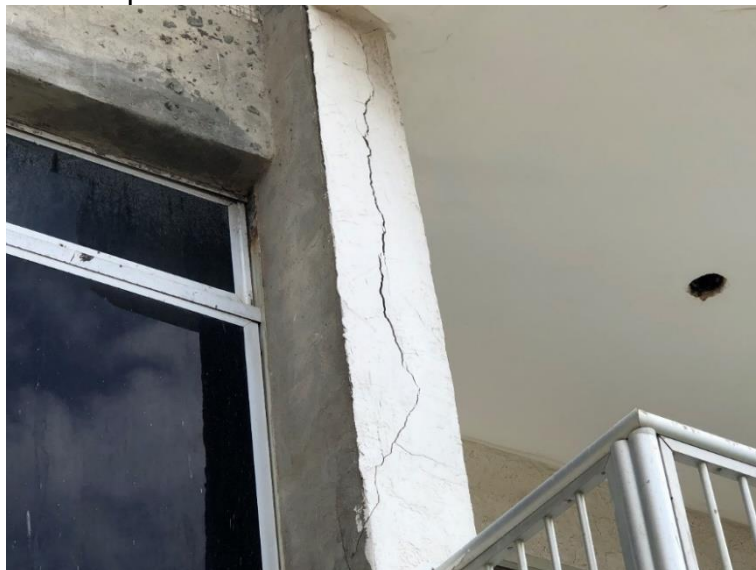
Figura 23 - Fissuras em pilar
