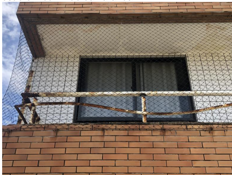
Figura 29 - Corrosão em corrimão da varanda
