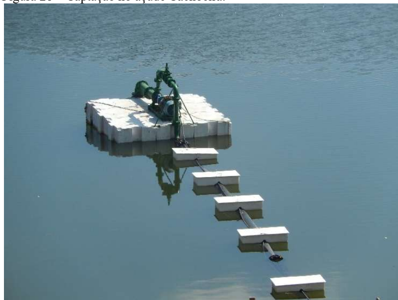
Figura 20 – Captação no açude Cachoeira.
