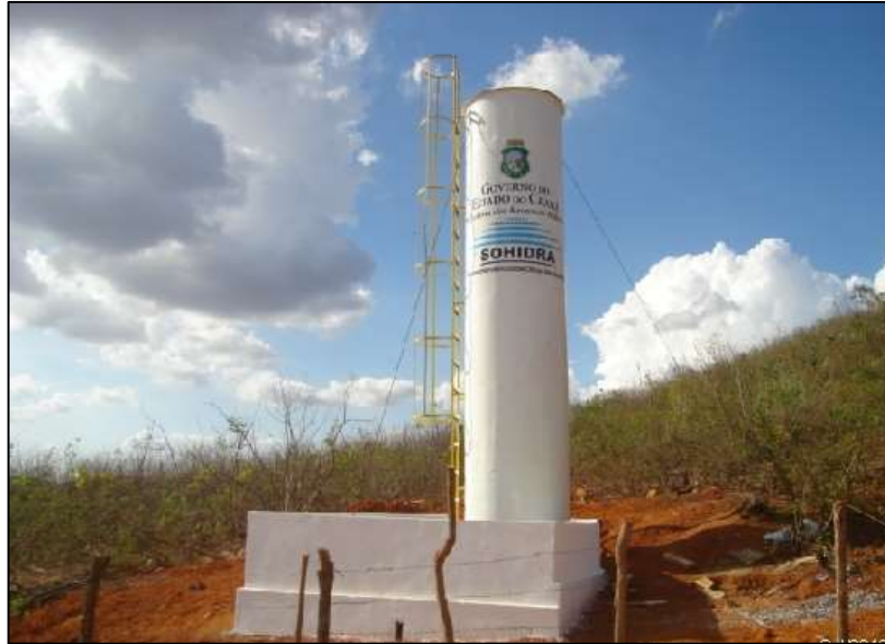
Figura 8 – Tanque de Alimentação Unidirecional na Adutora Pereiro.
