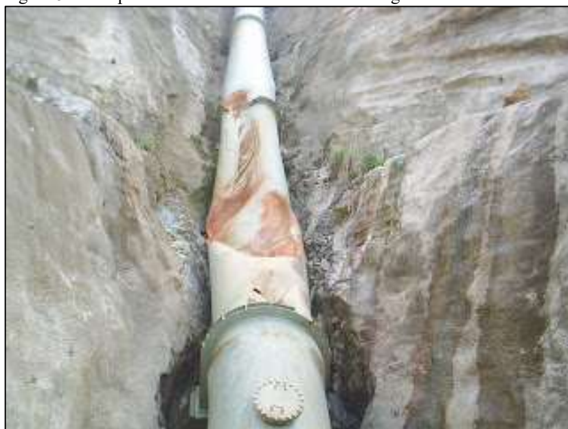
Figura 5 – Colapso de adutora de abastecimento de água.
