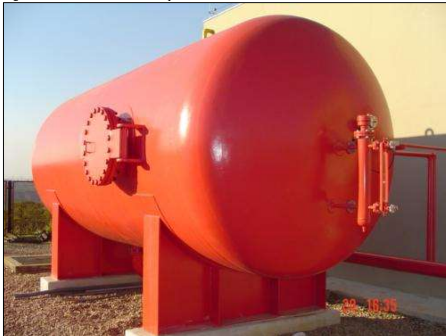
Figura 13 – Reservatório Hidropneumático instalado.
