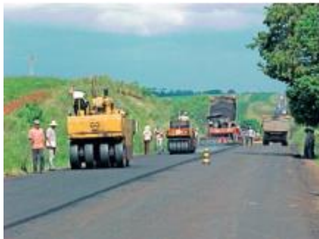
Figura 8 - Execução do recapeamento
