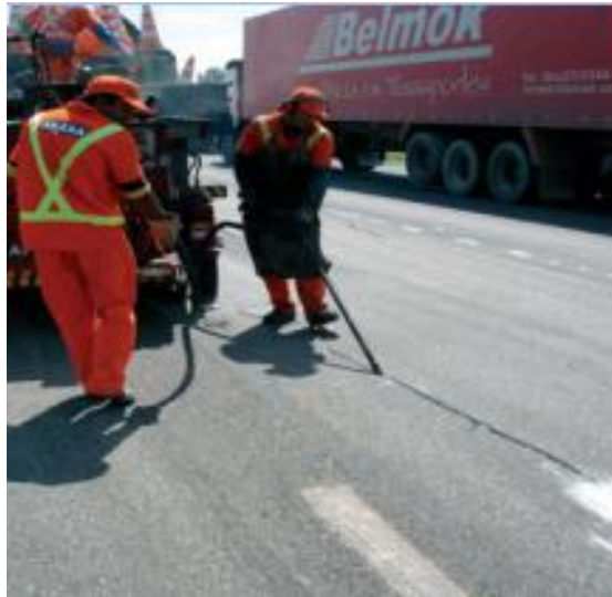
Figura 7 - Pavimento após a selagem de trincas
