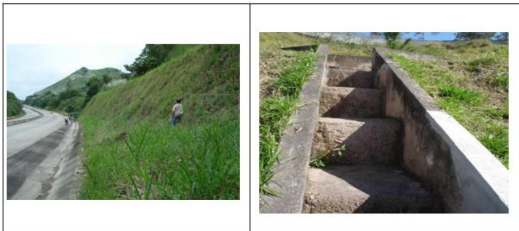
Figura 5 - Dispositivos de drenagem superficial
