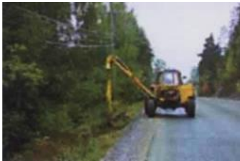
Figura 3 - Corte da vegetação do entorno da rodovia
