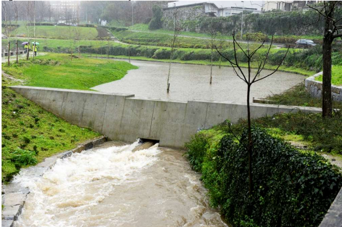
Figura 12 – Reservatório de detenção.
