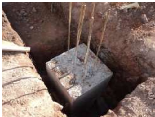
Figura 4 – Bloco de fundação in loco
