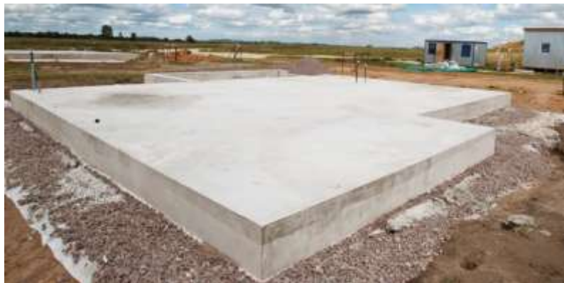
Figura 6 – Exemplificação de placa de fundação: o Radier
