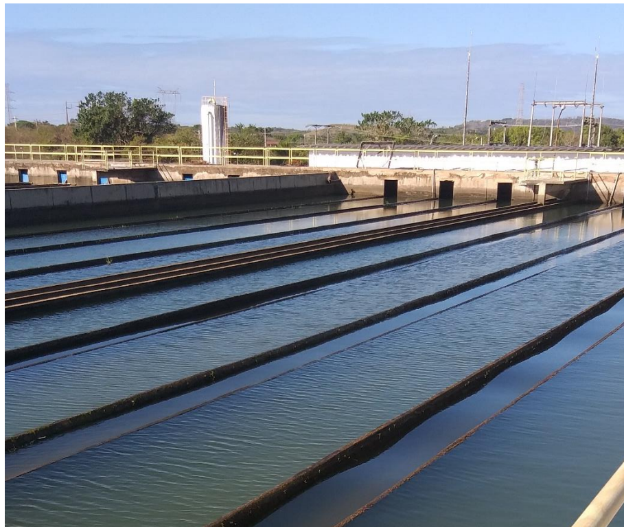
Figura 5 - Tanque de decantação da ETA Gavião em Pacajus – CE.
