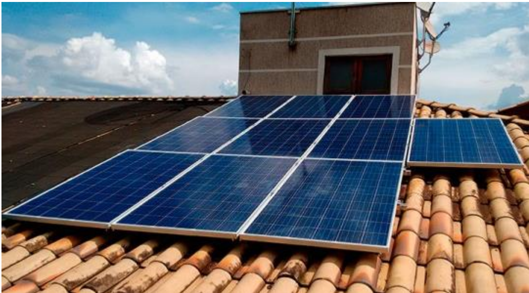
Figura 10 - Painéis solares fotovoltaicos.
