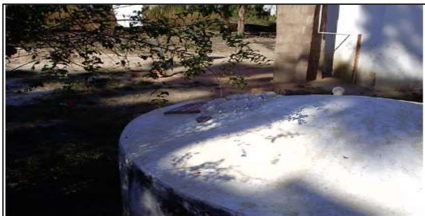
Figura 11 – Exposição Inadequada da Água ao Sol
