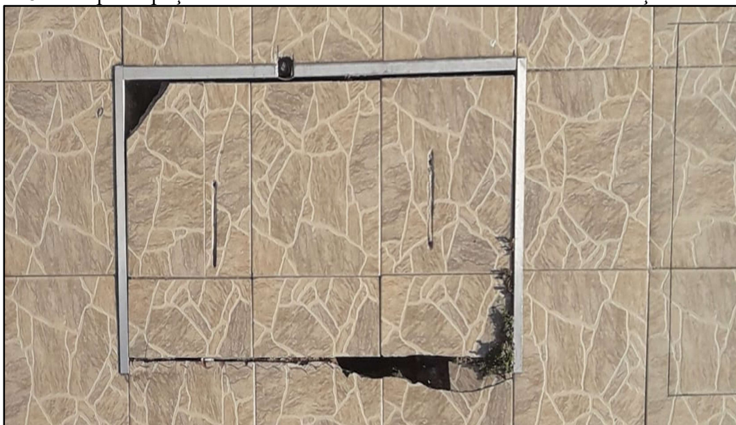
Figura 18 - Tampa do poço artesiano danificada com facilidade de contaminação
