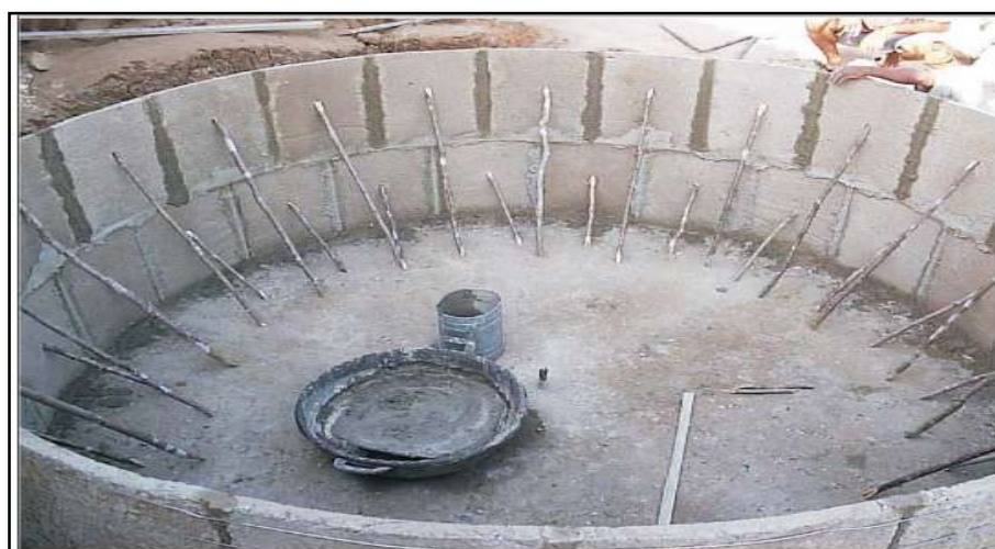
Figura 6 – Construção de cisternas de placas no Ceará
