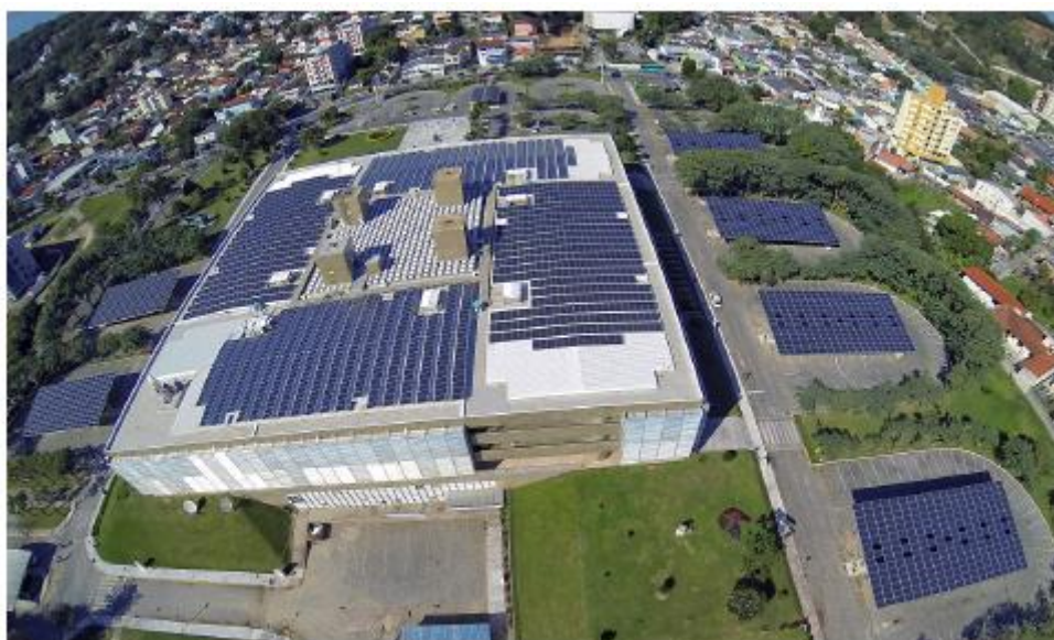
Figura 5 - Edifício Sede da Eletrosul em Florianópolis-SC, com geradores solares fotovoltaicos integrados na cobertura do prédio e nos estacionamentos, somando 1 MWp de potência
