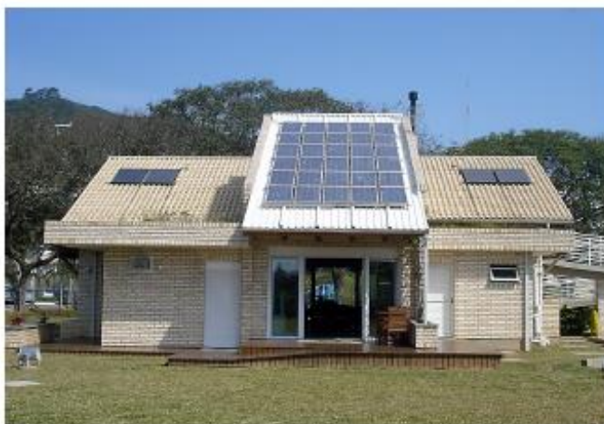
Figura 4 - Casa Eficiente Eletrosul em Florianópolis-SC, com um gerador solar fotovoltaico de 2 kWp integrado em seção do telhado
