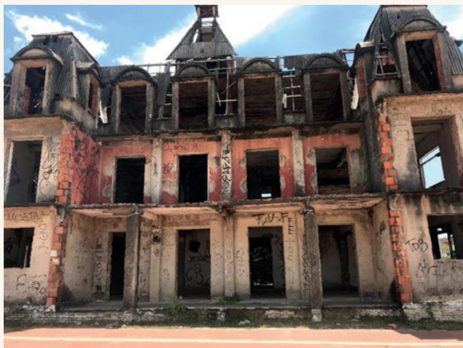
**Figura 3.16** Fachada Sudeste. Nota-se o destelhamento da cobertura.
