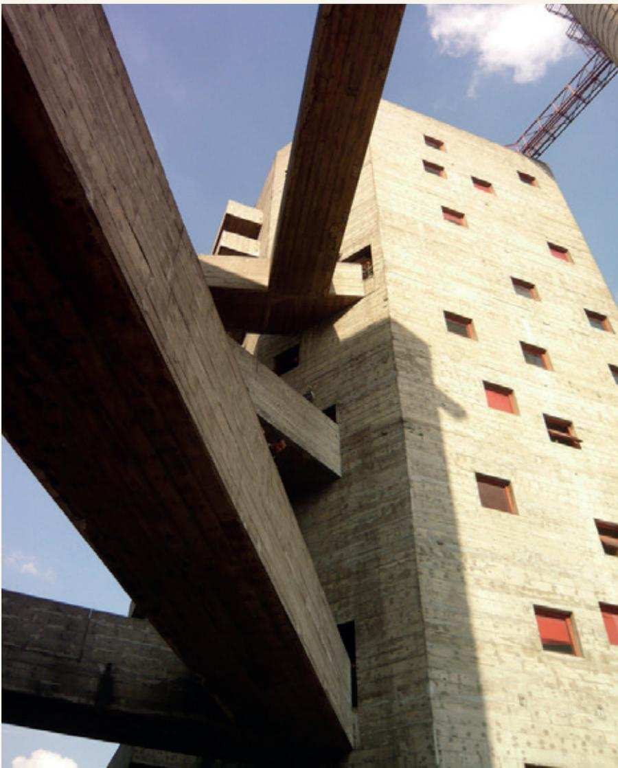
**Figura 2.19** Marcas dos moldes de tábuas horizontais de madeira e passarelas.
