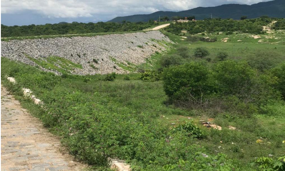
Figura 31 – Açude Sousa vista da parede de barramento.
