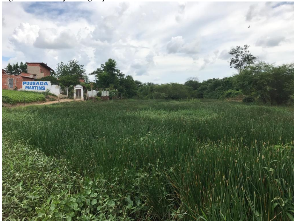
Figura 24 – Presença de vegetação no leito do Rio Canindé.
