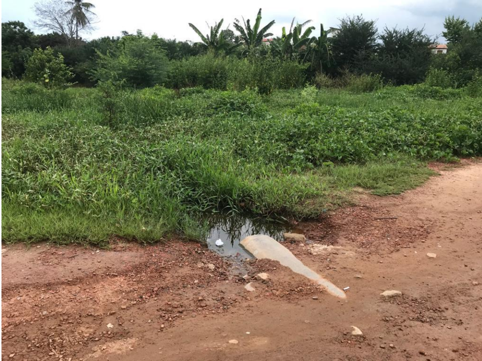
Figura 25 – Tubulação de esgoto no leito do Rio Canindé.
