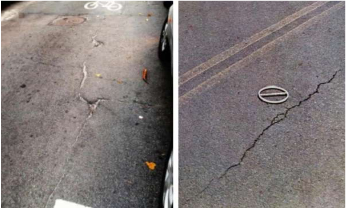
Figura 9 – Trincas Longitudinais
