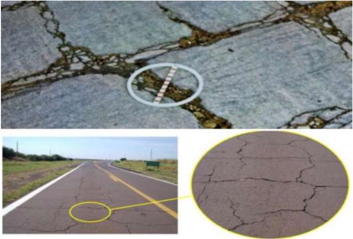
Figura 6 – Trincas em blocos
