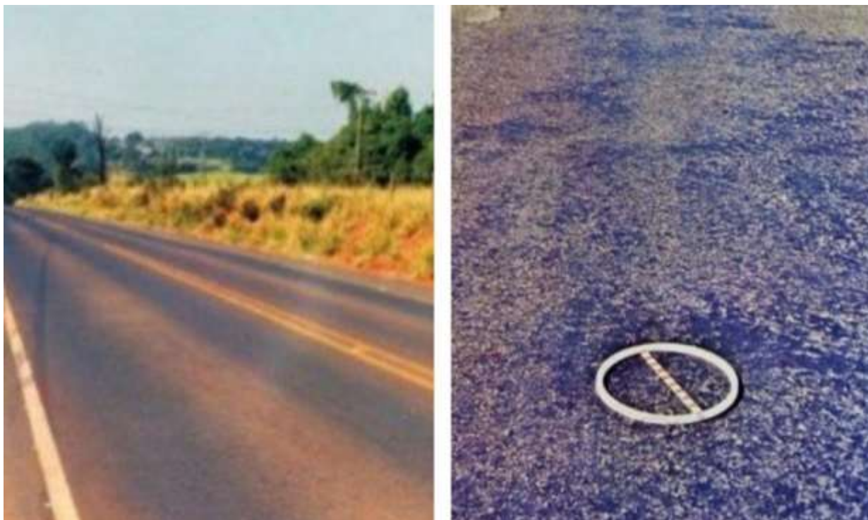
Figura 12 – Exsudação nas trilhas de roda.
