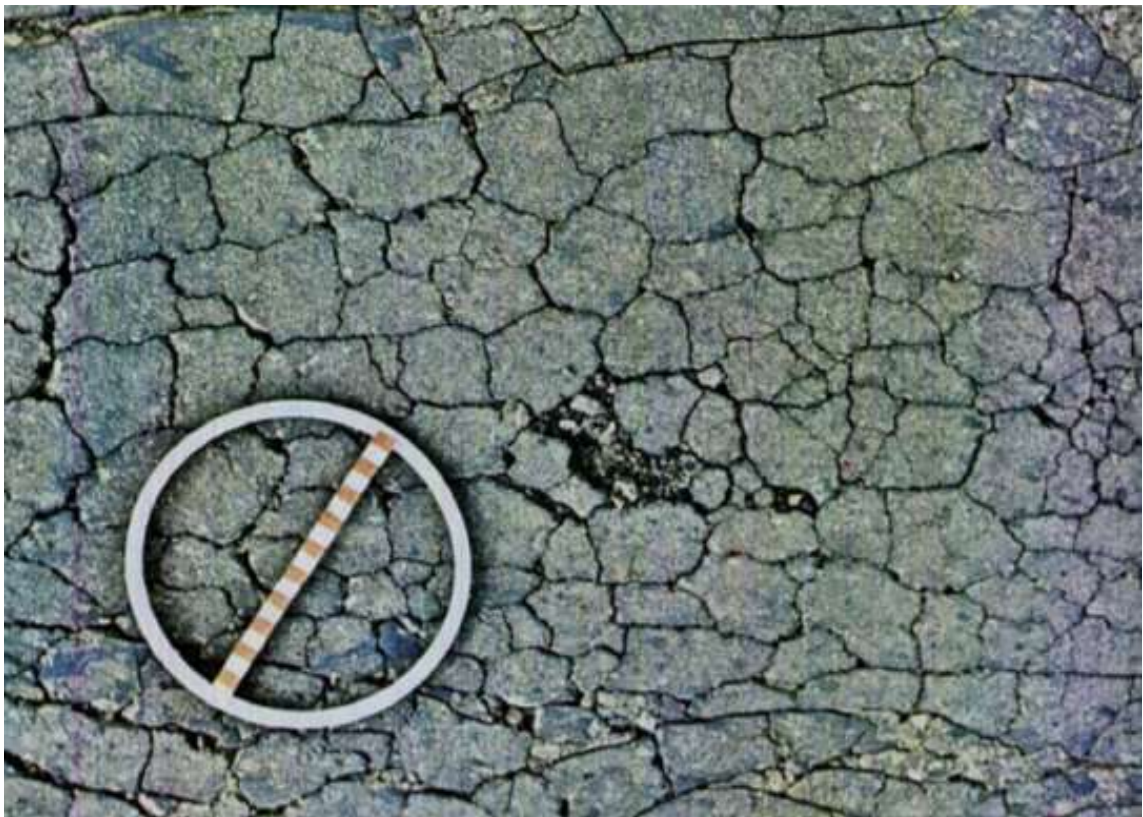
Figura 7 – Trinca em couro de jacaré
