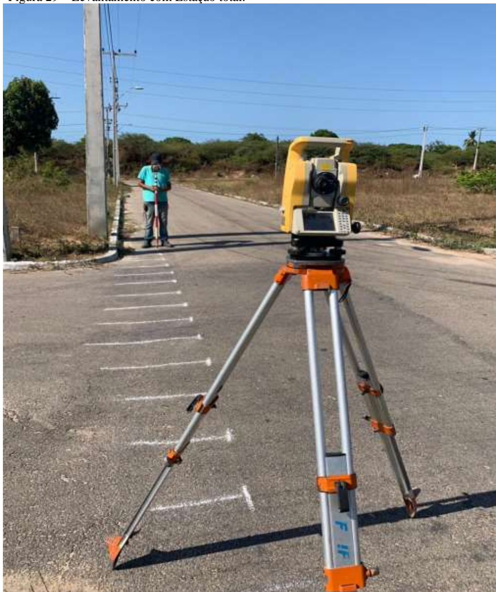
Figura 29 – Levantamento com Estação total.
