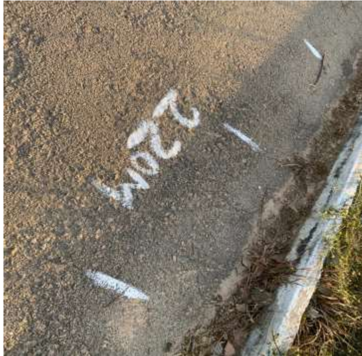
Figura 32 – Irregularidades na Trilha de roda externa sentido 2
