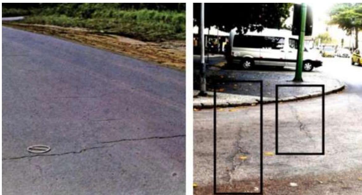
Figura 8 – Trincas Transversais
