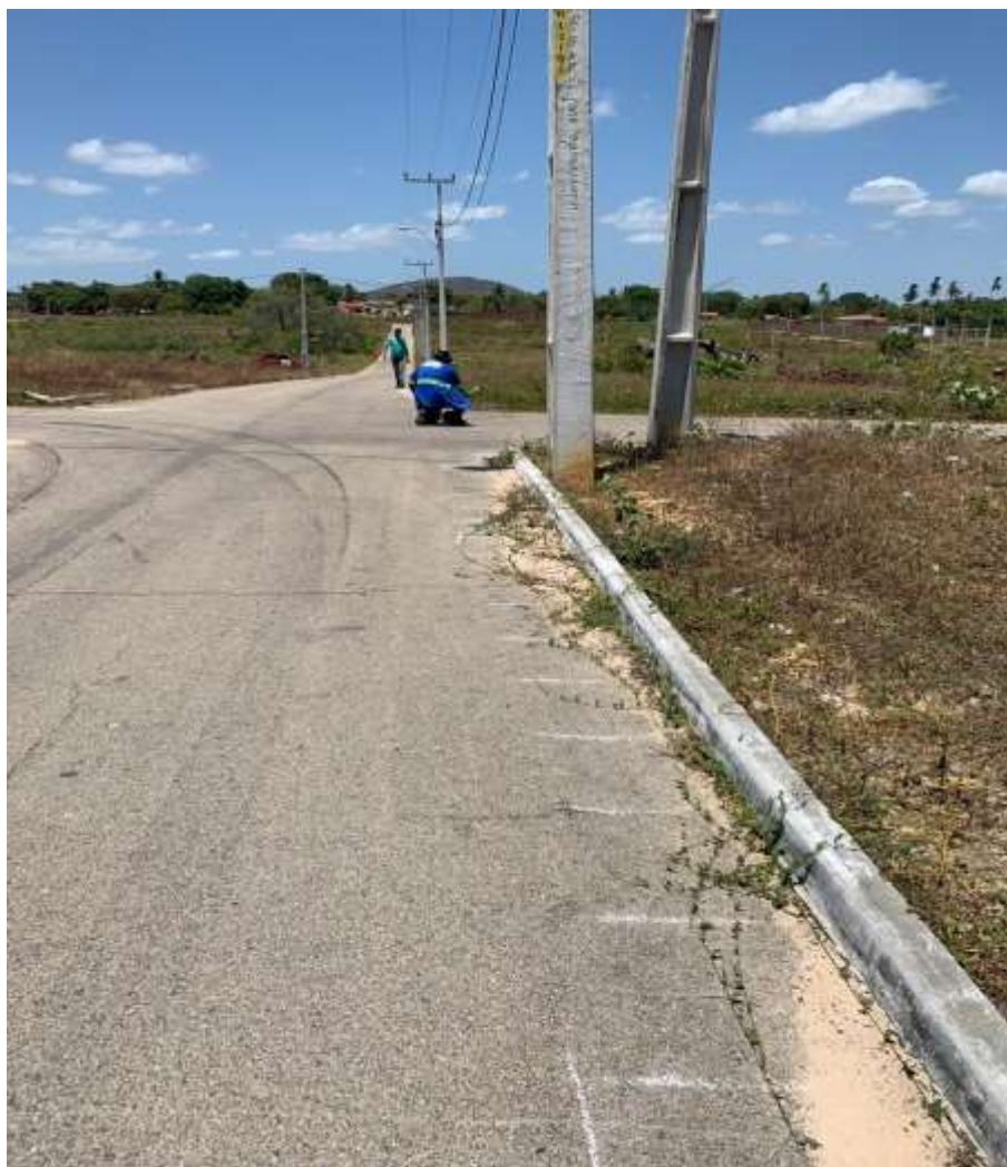
Figura 27 – Marcação realizada com giz com uma trena de 20 m antes do levantamento.
