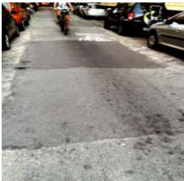
Figura 11 – Dois remendos consecutivos em uma faixa de rolamento
