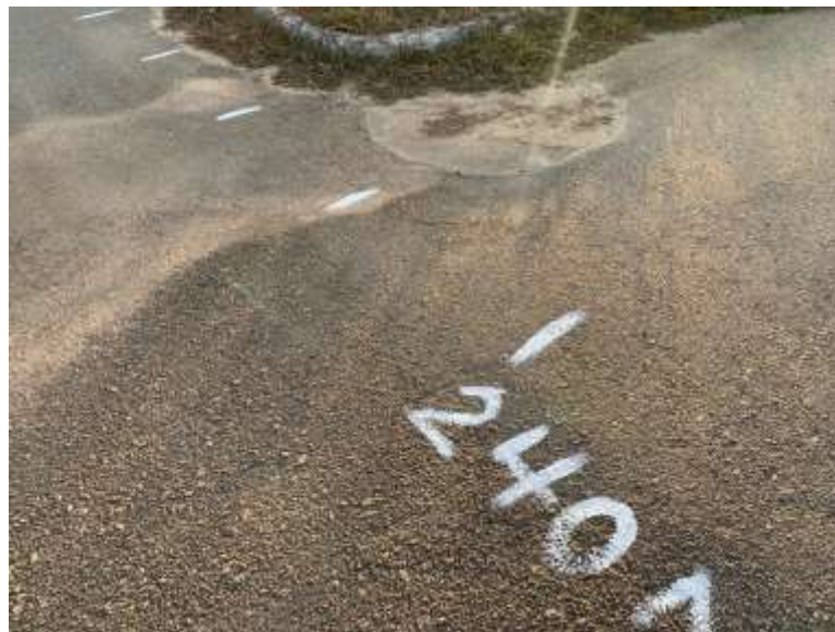
Figura 33 – Desnível pontual na Trilha de roda externa sentido 1 a 240 metros do início do levantamento
