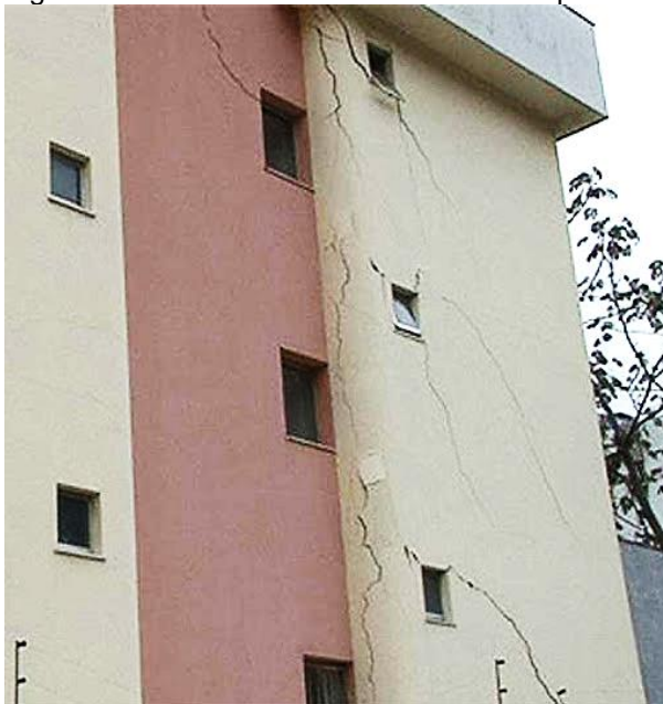
Figura 7 – Rachaduras na fachada de um prédio
