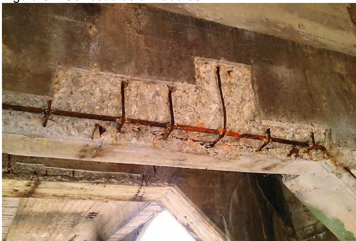
Figura 8 – Corrosão de armaduras
