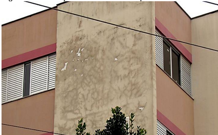
Figura 6 – Infiltração em uma fachada predial
