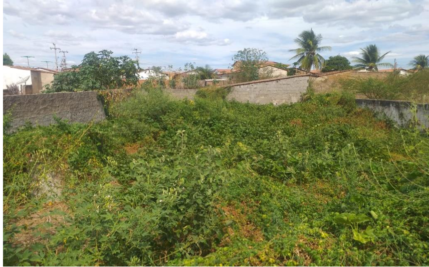
Figura 49 – Estação coberta por vegetação no bairro Monte Castelo.
