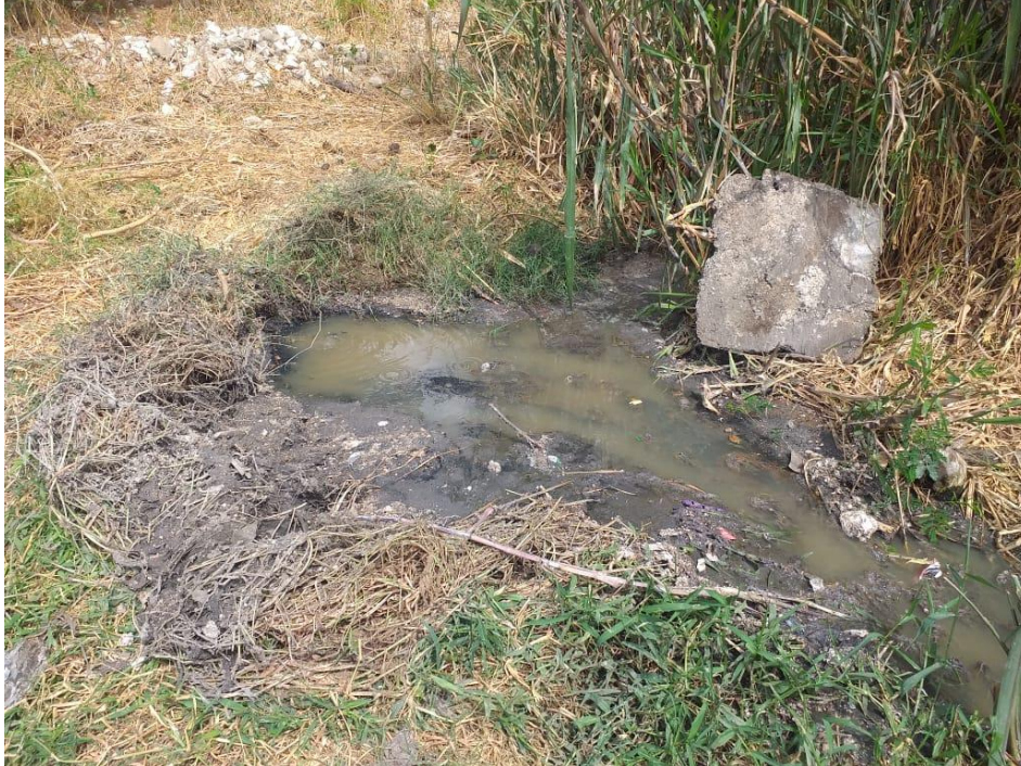
Figura 47 – Esgoto a céu aberto na estação de tratamento de esgoto da Vila São Pedro.
