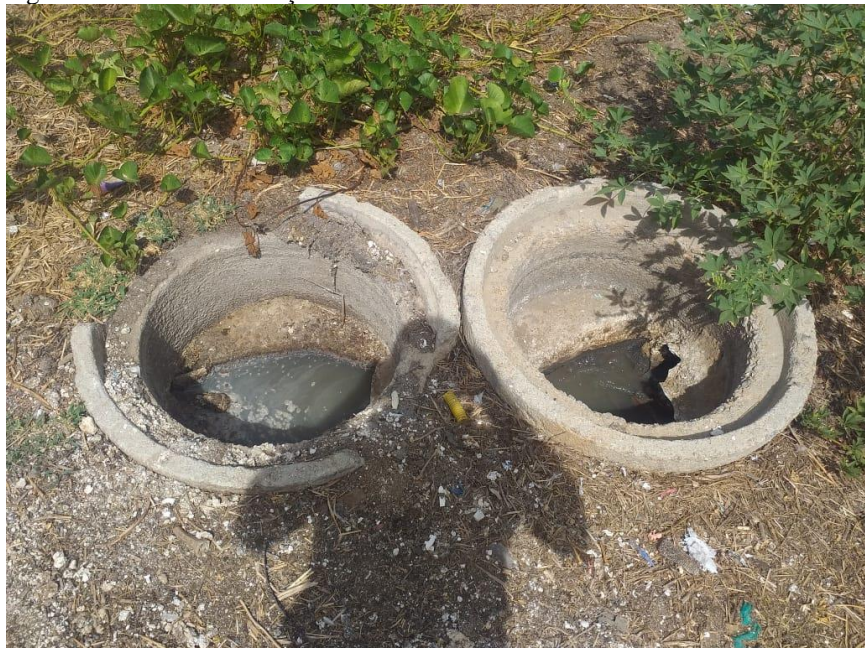
Figura 44 – Fossas da estação da Vila Monsenhor Holanda em Tamboril
