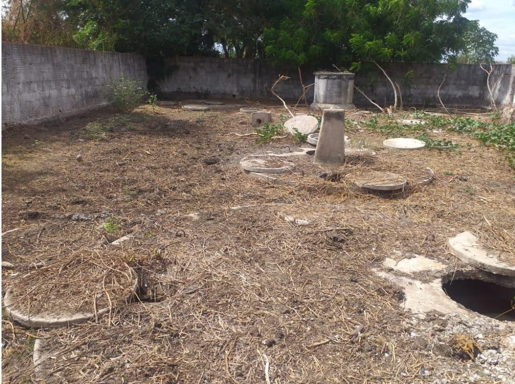
Figura 43 – Situação da estação de tratamento de esgoto da Vila Monsenhor Holanda em Tamboril
