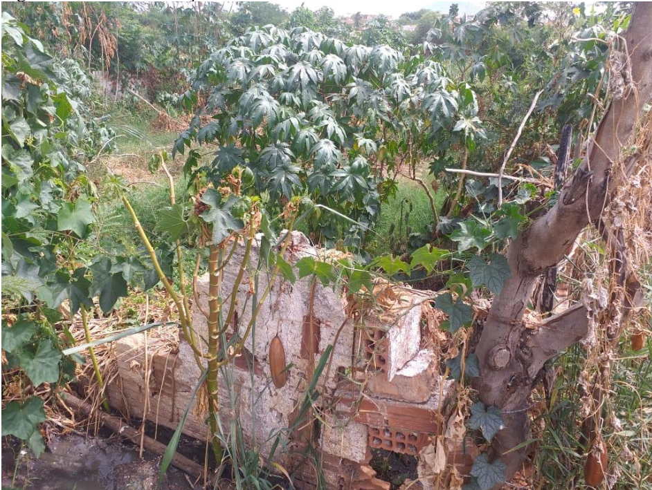
Figura 46 – Muro da estação de tratamento da Vila São Pedro.
