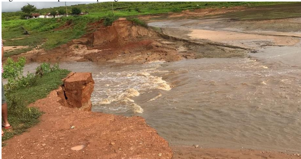
Figura 62 – Rompimento da passagem molhada na zona rural de Tamboril.
