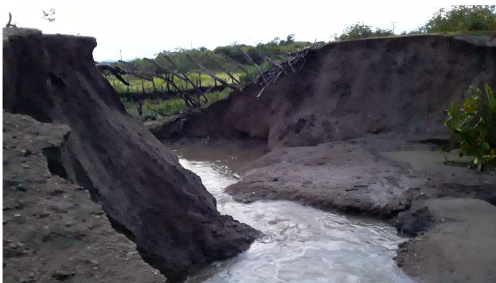
Figura 63 – Rompimento de açude em propriedade particular.
