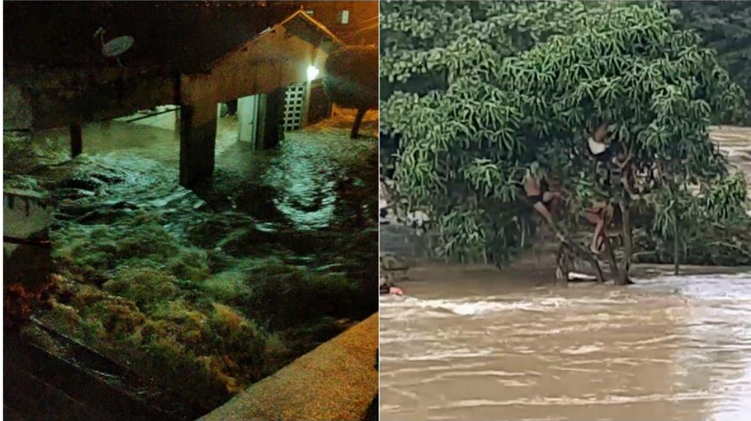
Figura 64 – Rompimento de açude em propriedade particular.
