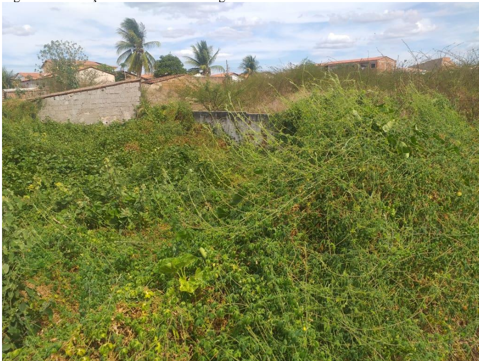
Figura 48 – Estação de tratamento de esgoto do bairro Monte Castelo.
