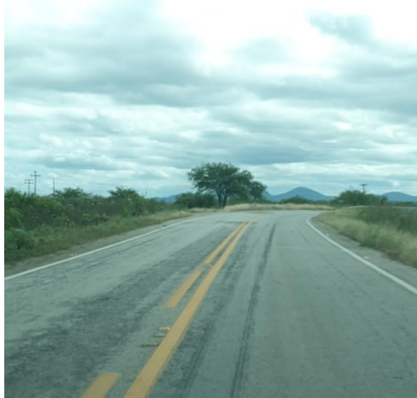
Figura 38 – Borda de pista sem dobra visual visualizada no trecho
