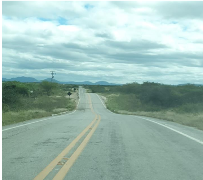
Figura 34 – Abaulamento visualizado no trecho
