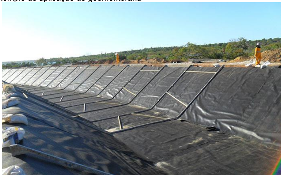
Figura 6 - Exemplo de aplicação de geomembrana
