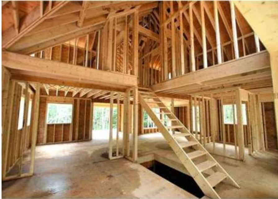
Figura 5 – Sistema Wood Frame
