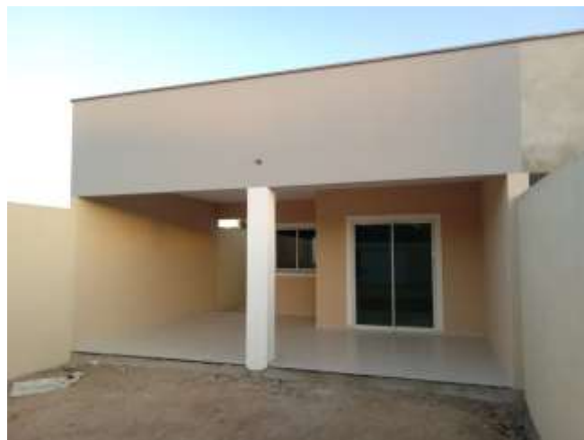
Figura 20 – Residência unifamiliar terminada
