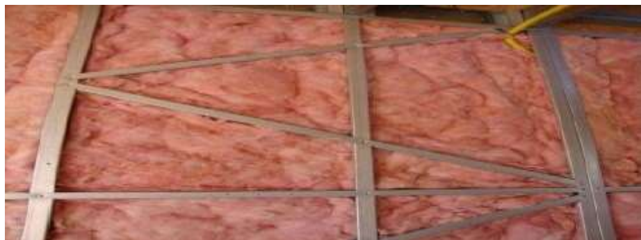
Figura 10 – Utilização de lã de vidro
