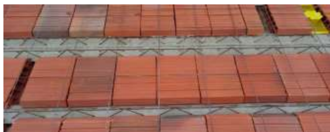
Figura 19 – Elementos de montagem da laje treliçada
