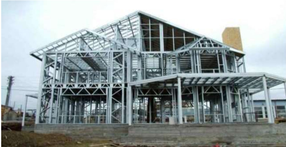
Figura 6 – Estrutura do sistema Light Steel Frame
