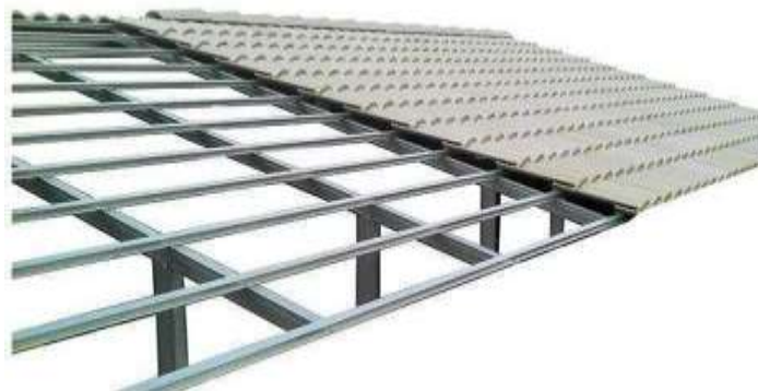
Figura 11 – Coberta Steel Frame
