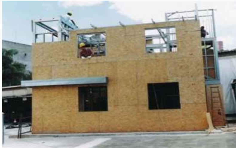
Figura 9 – Placas OSB como fechamento dos perfis
