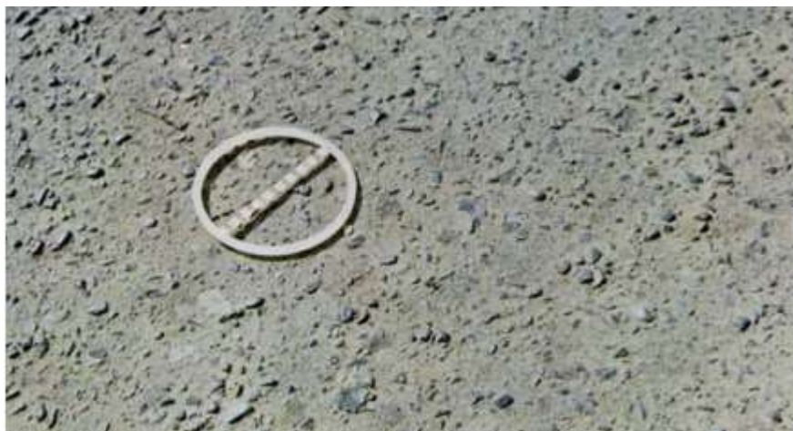
Figura 14 – Desgaste do revestimento asfáltico do pavimento
