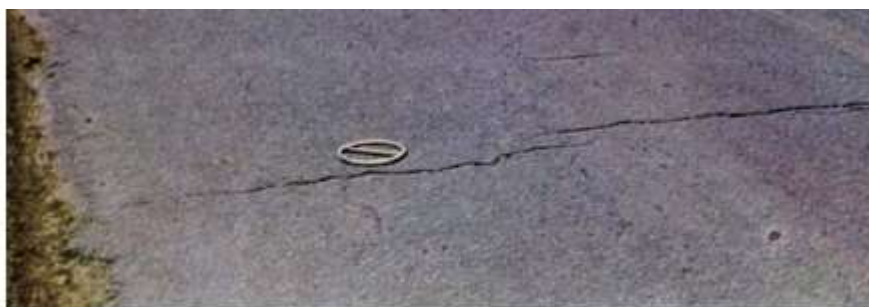
Figura 5 – Representação fotográfica de uma trinca transversal
