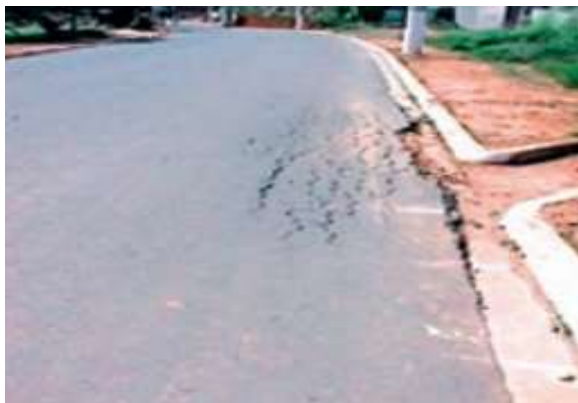
Figura 11 – Afundamento de consolidação local (1)
