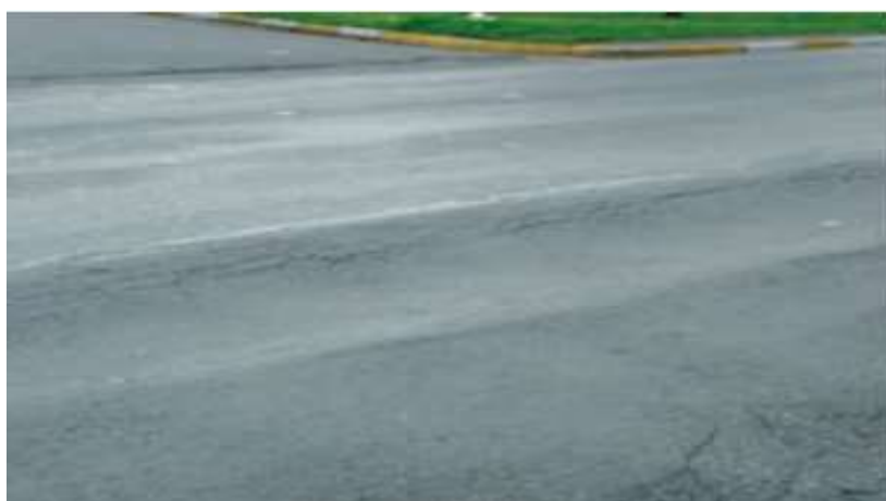
Figura 10 – Afundamento de trilha de roda (2)
