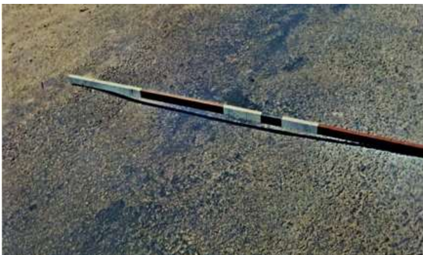
Figura 12 – Afundamento de consolidação local (2)
