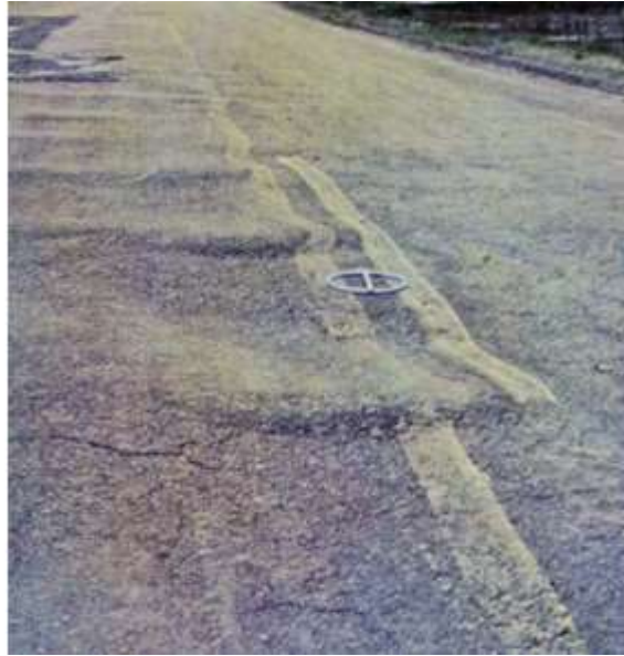
Figura 13 – Corrugação no eixo da pista
