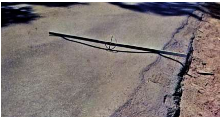
Figura 9 – Afundamento de trilha de roda (1)
