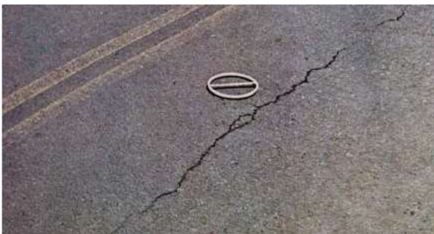
Figura 6 – Representação fotográfica de uma trinca longitudinal
