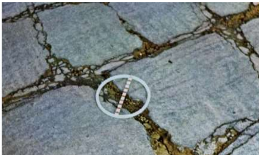
Figura 7 - Representação fotográfica de uma trinca interligada tipo bloco
