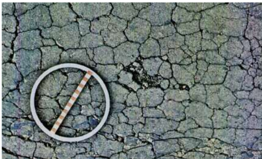
Figura 8 - Representação fotográfica de uma trinca interligada tipo couro de jacaré
