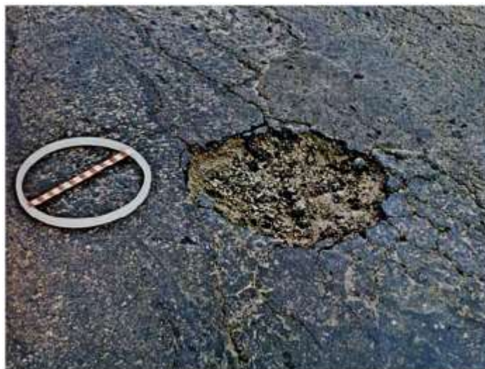
Figura 15 – Defeito panela acometendo o revestimento de um pavimento
