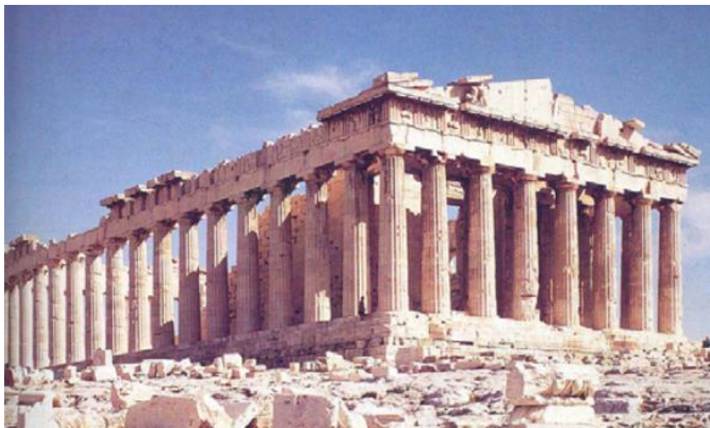
Figura 2 – Pilares e vigas na estrutura do Panteão
