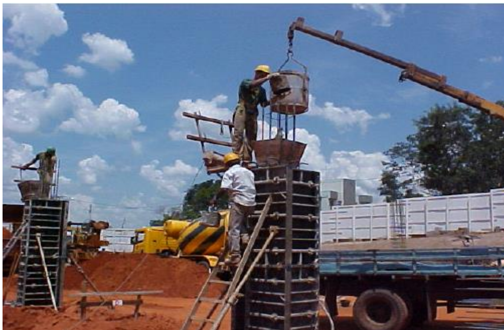
Figura 10 – Pilar sendo concretado
