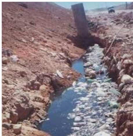
Figura 4 – Vazamento de lixiviado no pé do talude no ASMOC.
