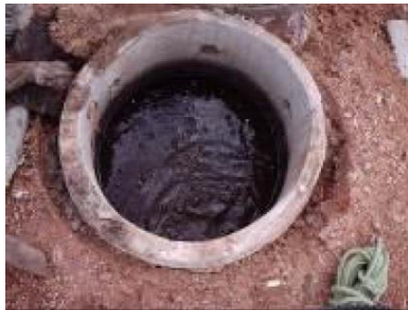
Figura 3 – Tubulação para drenagem de gases com a presença de lixiviado no ASMOC.
