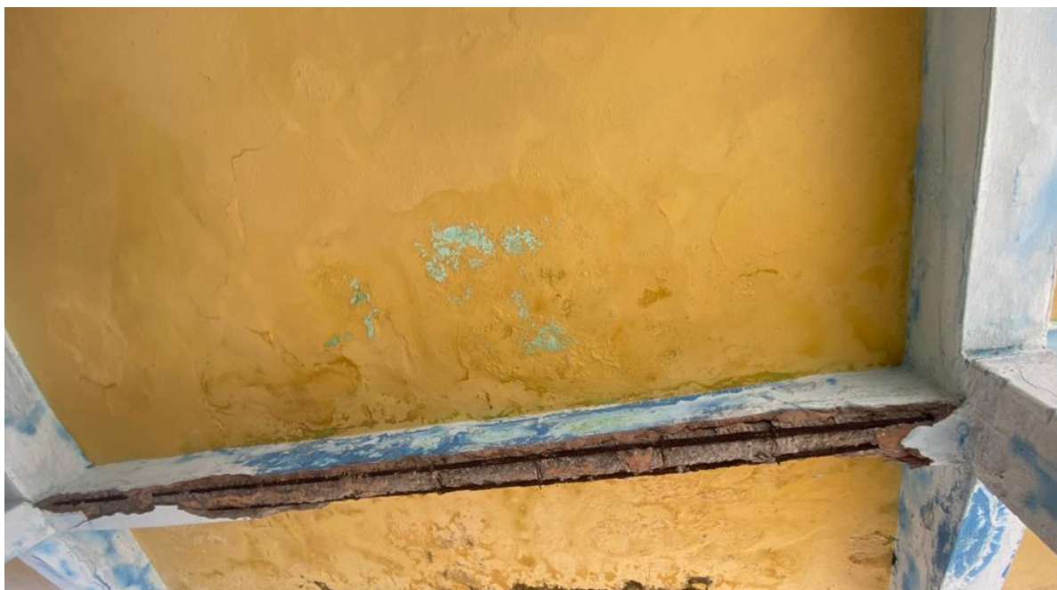
Figura 13 – Corrosão em uma viga de concreto armado
