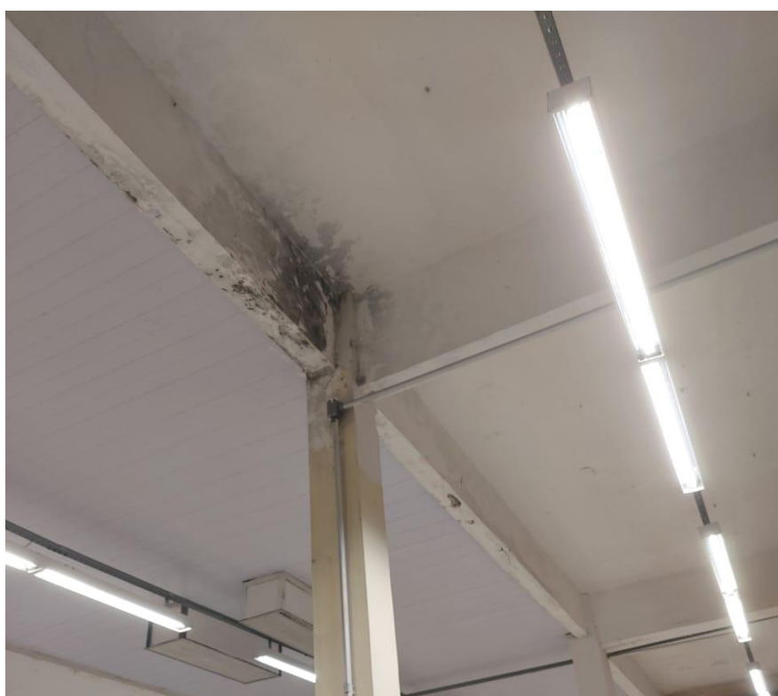
Figura 6 – Bolores em viga de concreto
