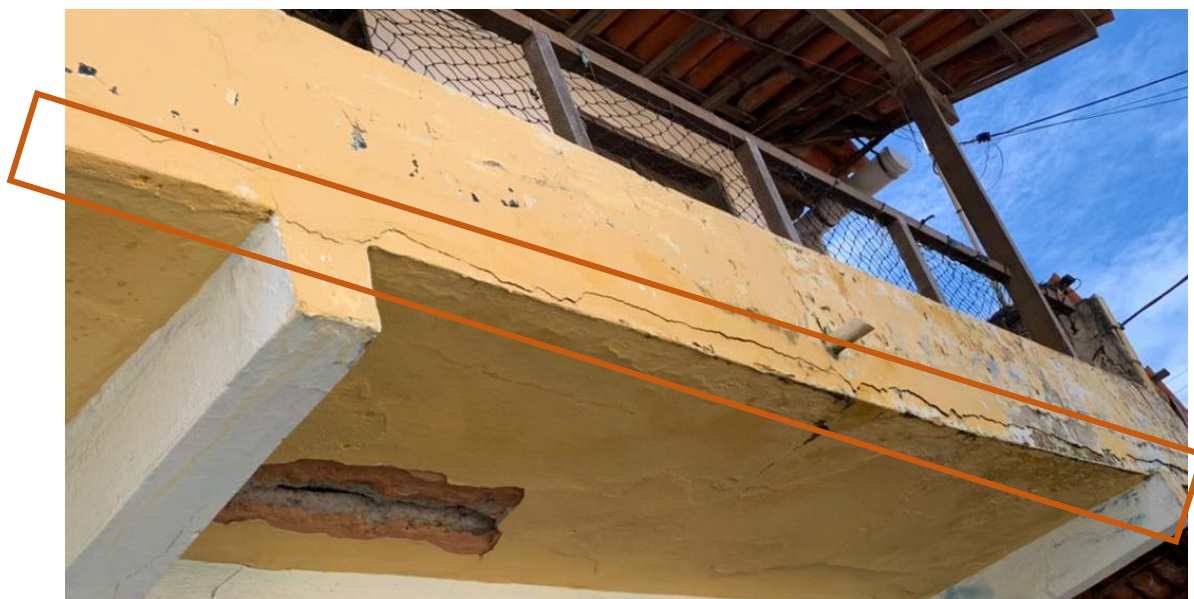
Figura 14 – Fissura de revestimento/estrutural por falta de manutenção
