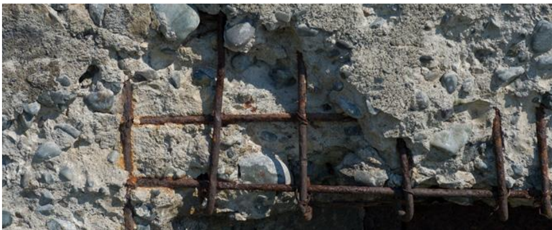
Figura 10 – Desagregação do concreto em uma viga.
