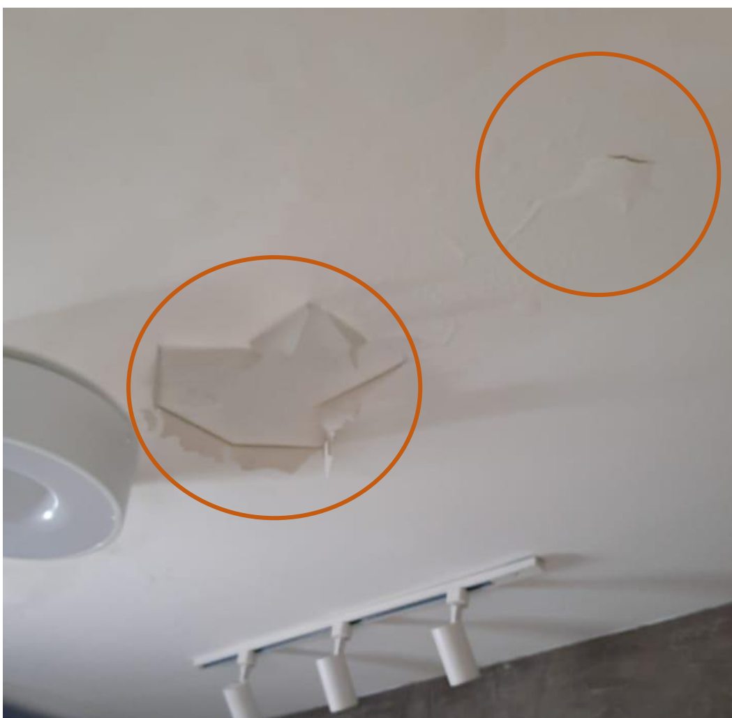
Figura 17 – Descamação de uma pintura decorrente de infiltração
