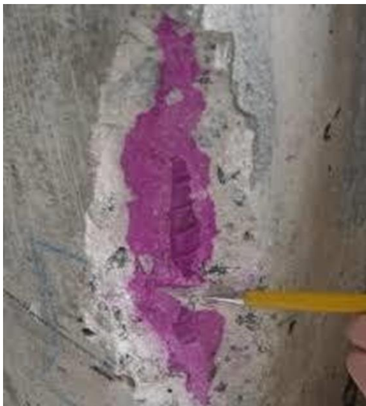
Figura 5 – Conferência de carbonatação por aplicação de fenolftaleína
