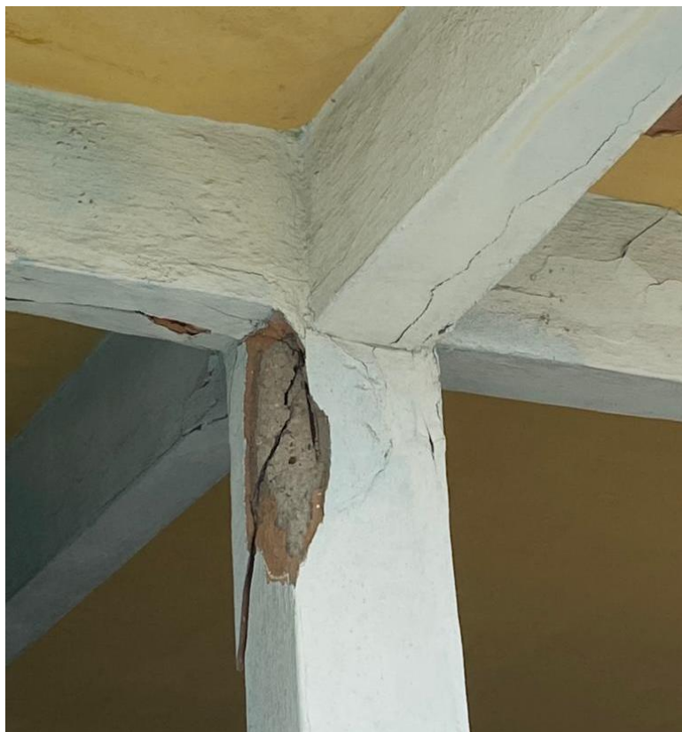
Figura 15 – Fissuras estruturais ocasionadas pelo cisalhamento
