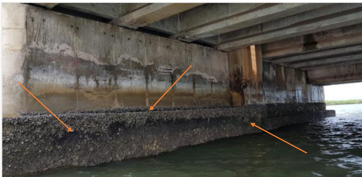
Figura 8 – Desgaste do concreto por erosão.
