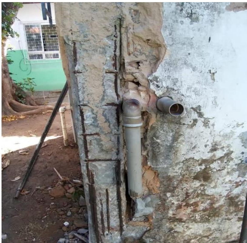
Figura 4 – Estrutura com processo de corrosão
