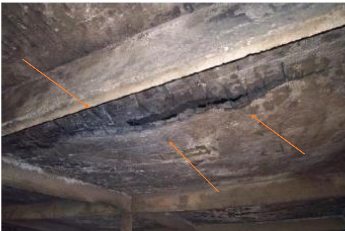
Figura 9 – Desgaste de concreto por cavitação.
