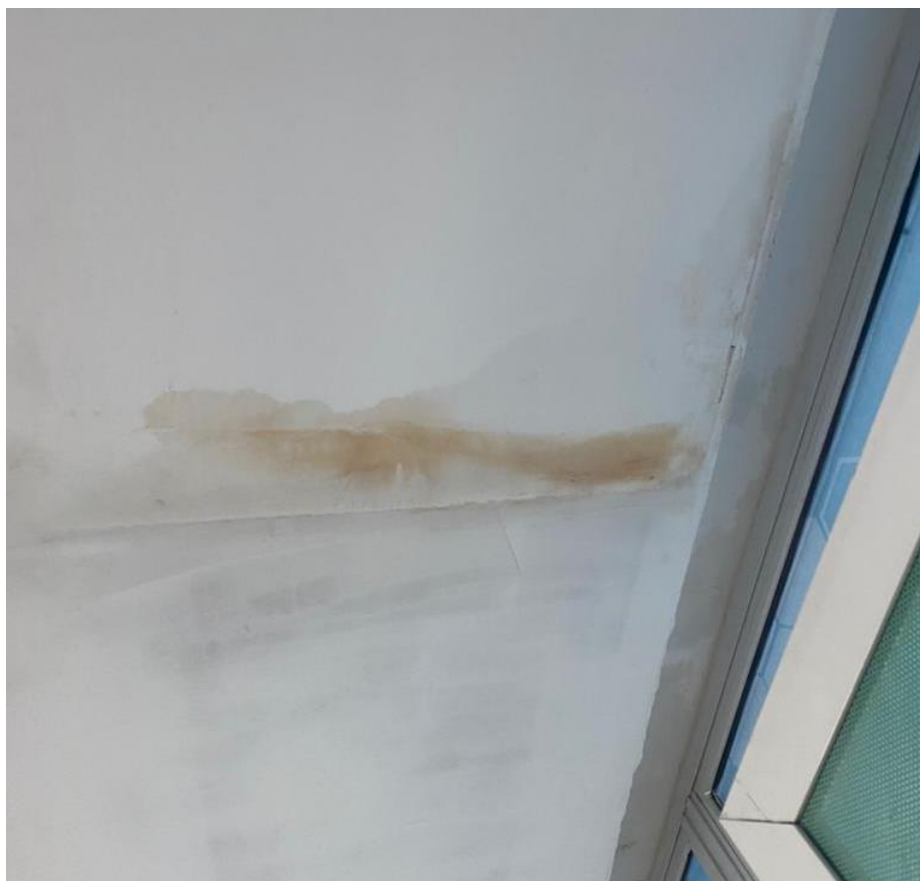
Figura 16 – Bolores decorrente de infiltração
