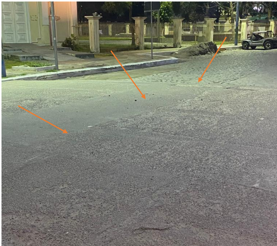
Figura 7 – Desgaste do concreto por abrasão.
