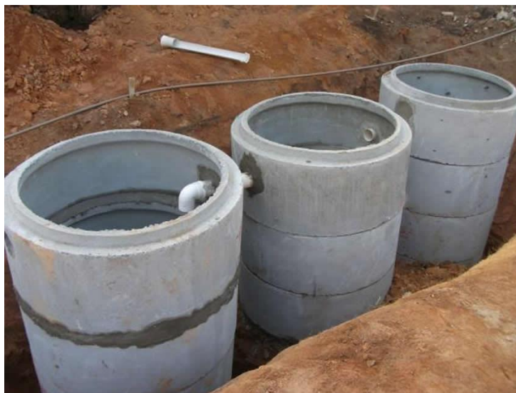
Figura 13 – Fossa séptica pré-moldada.
