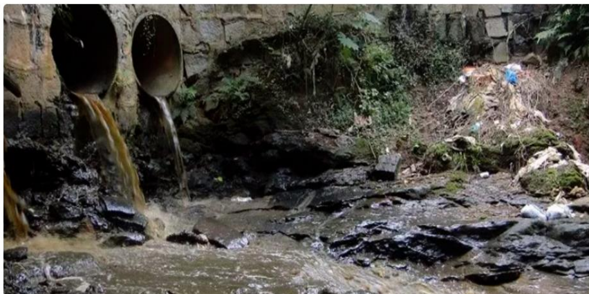
Figura 11 – Esgoto a céu aberto sendo despejado próximo a um rio.
