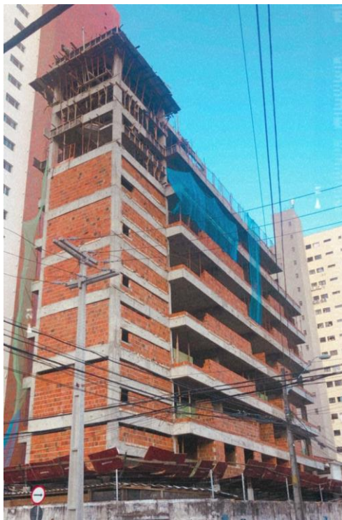
Figura 14 – Vista externa da superestrutura concluída
