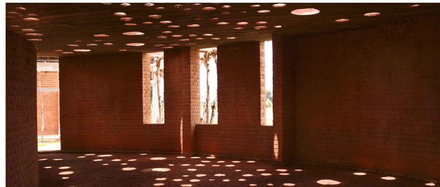
Figura 14. Parte interna da biblioteca ainda em construção. Fonte: ArchDaily, 2012.
