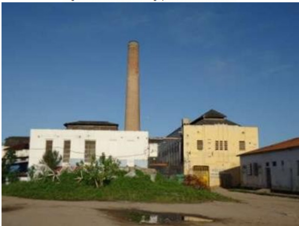
Figura 23: Fachada lateral do galpão central com chaminé
