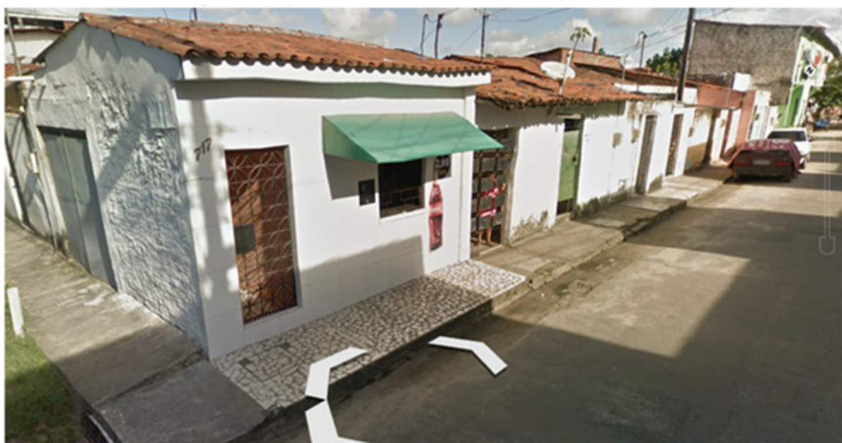
Figura 32: Edificação do uso misto estilo “janelinha” na Rua Santa Rosa, 717
