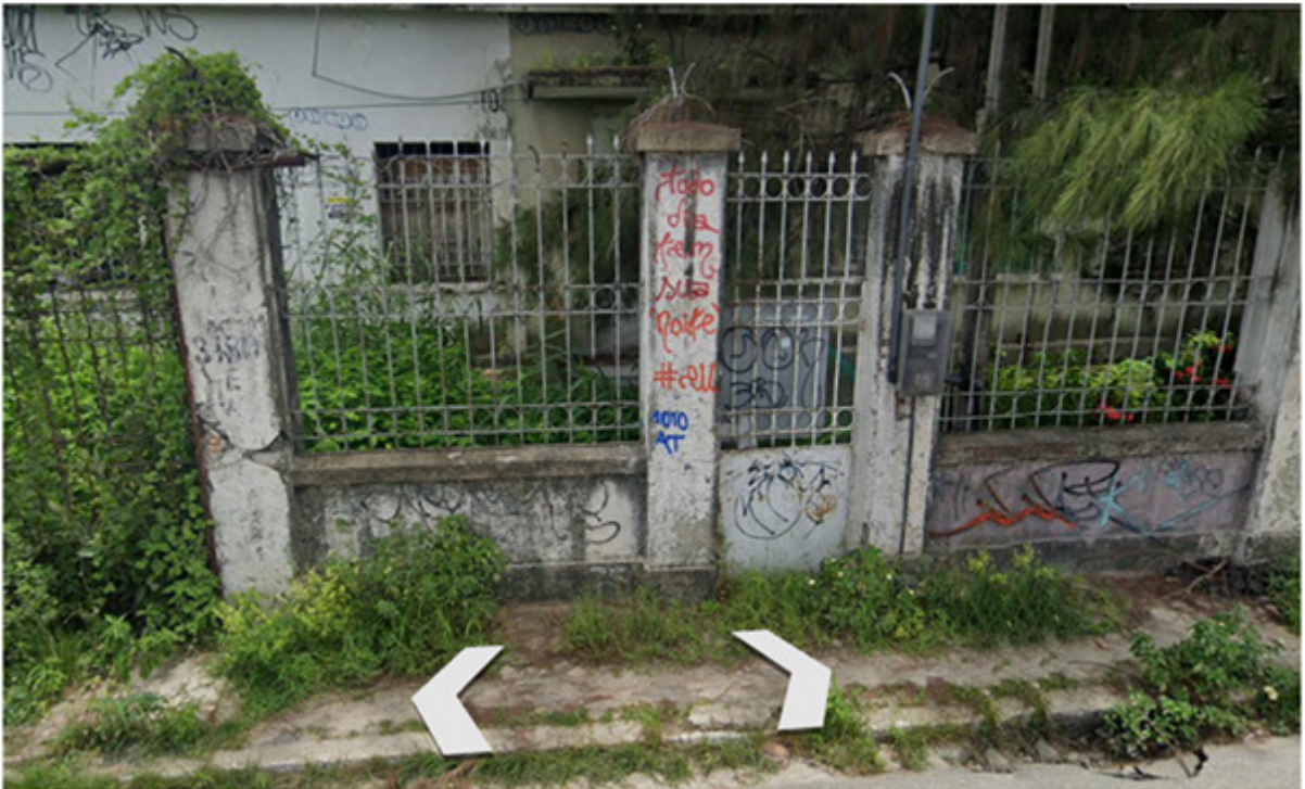
Figura 27: Visada D – Antigo acesso social pela avenida Francisco Sá
