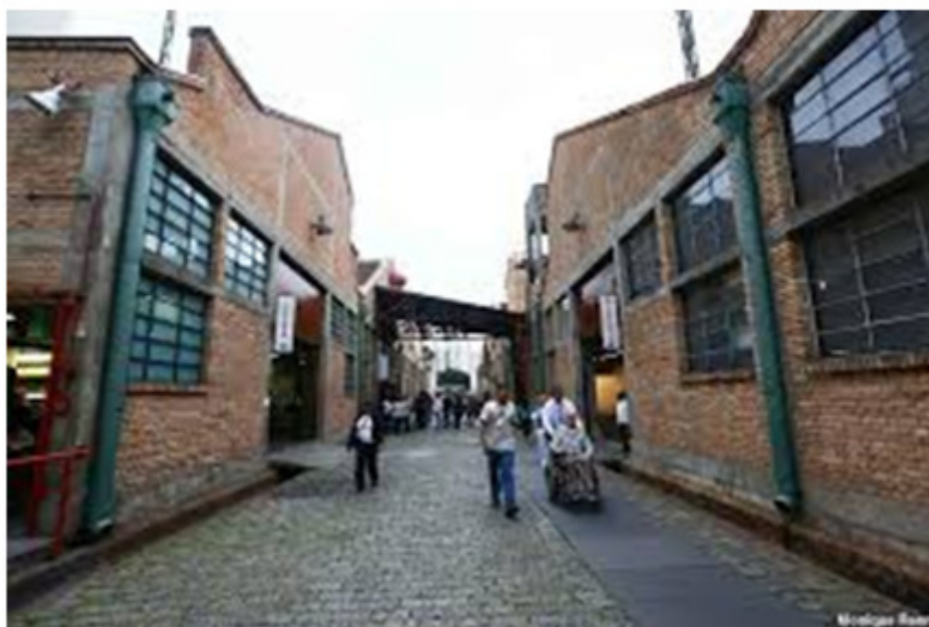
Figura 7: Galpões da Fábrica da rua Clélia, 93, transformados em SESC/Pompeia
