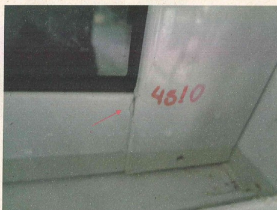
Foto nº. 04 Verificação da estanqueidade à água: PI-01: Infiltração entre a travessa inferior e o montante direito da folha direita, sem ocasionar respingos para a face interna (1').
