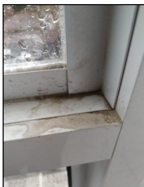
Figura 9 – Infiltração devido ao mal fechamento dos quadros
