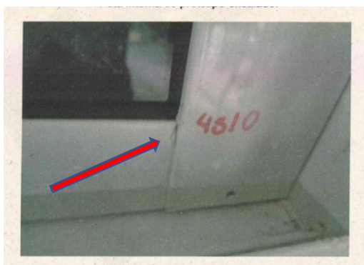
Figura 32 – Detalhe infiltração do protótipo LIS SL-40 EC
