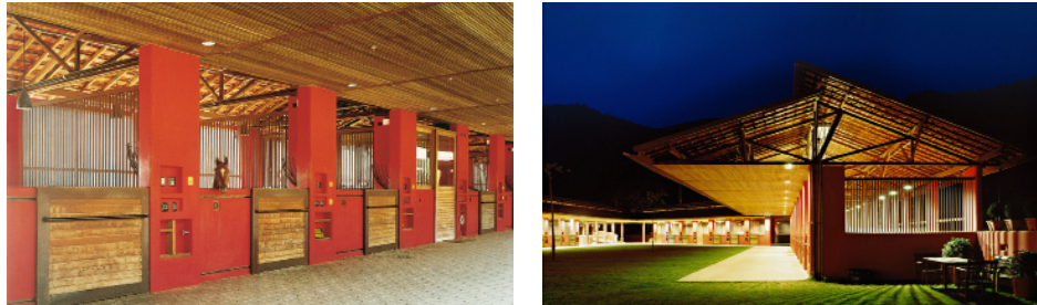
Imagem 03 - Centro Hipico Polonia - Baias e pista coberta
