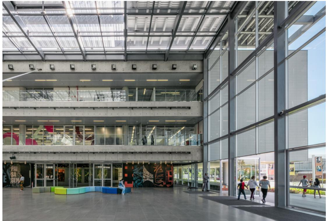
“Seu sistema de cobertura é composto de grelhas metálicas, vidro, extractores de ar e brises horizontais em alumínio perfurado para proteção solar, filtra a luz natural e serve de coroamento para esse espaço” (PEREIRA, 2019).
