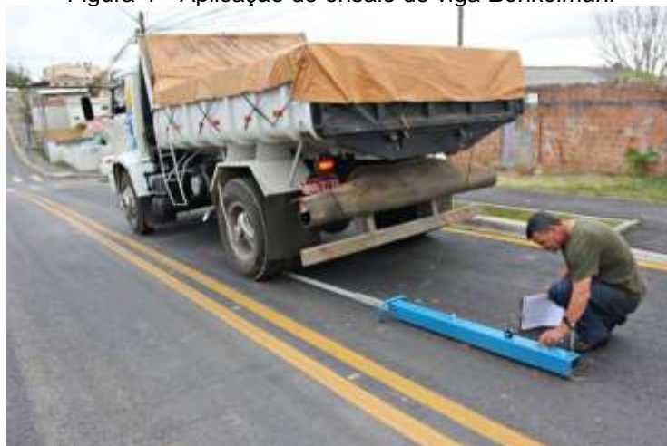
Figura 4 - Aplicação do ensaio de viga Benkelman .
