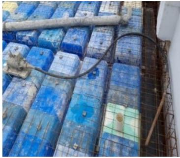
a) Equipamento de adensamento e tubo rígido para concretagem
