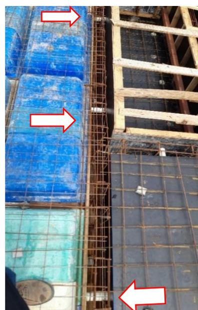
b) Compatibilização da tubulação de esgoto entre as vigas
