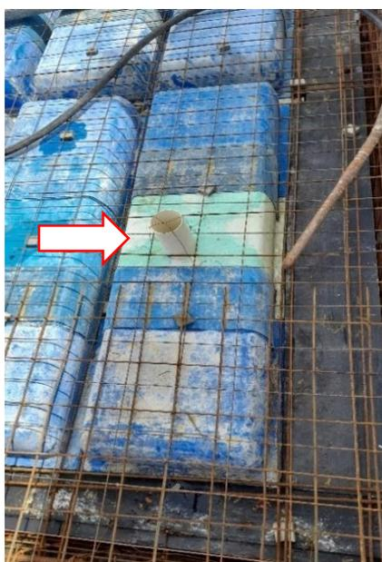
a) Compatibilização da tubulação de esgoto sobre a laje
