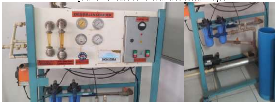
Figura 10 – Unidade demonstrativa de dessalinização
