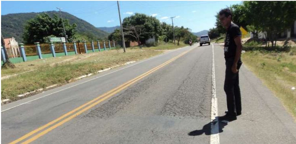
Figura 22 - Trinca de couro de jacaré com o pavimento fadigado em pouco tempo de uso
