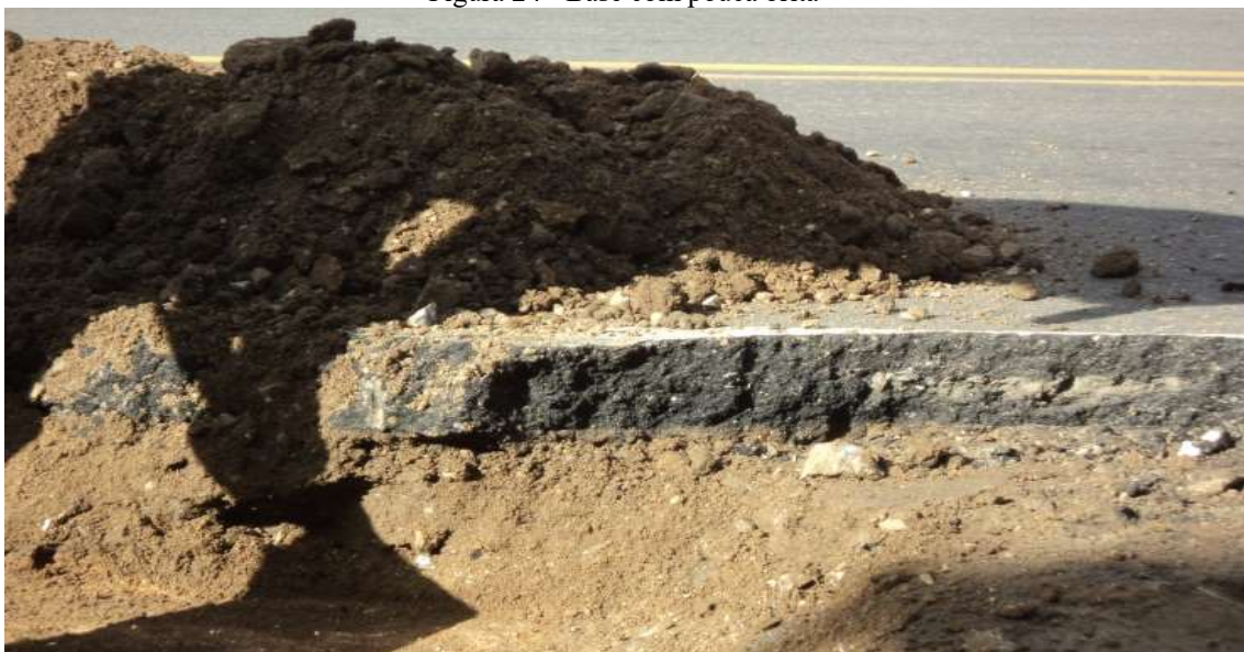
Figura 24 - Base com pouca brita
