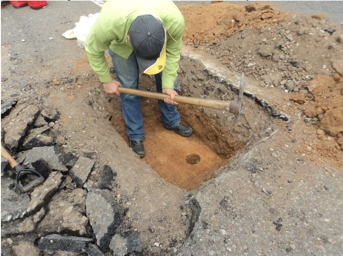
Figura 25 - Método de análise destrutiva nas camadas do pavimento.
