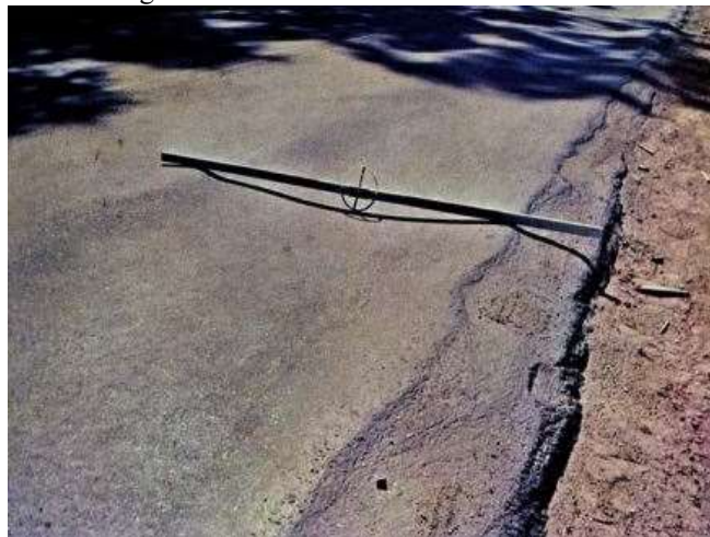
Figura 12 - Afundamento de trilha de roda
