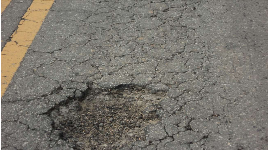
Figura 23 - Pavimento trincado severamente
