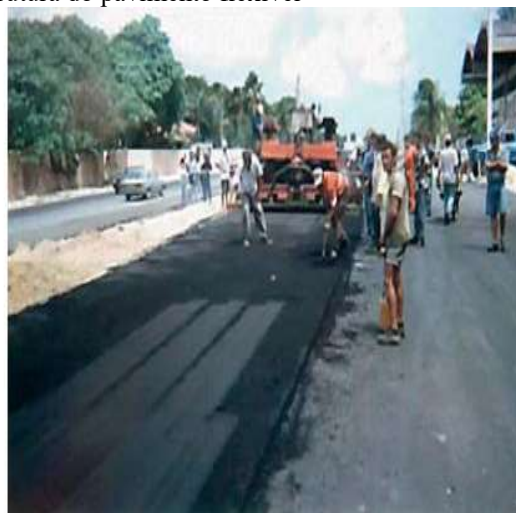
(b) Revestimento asfáltico sendo executado.
