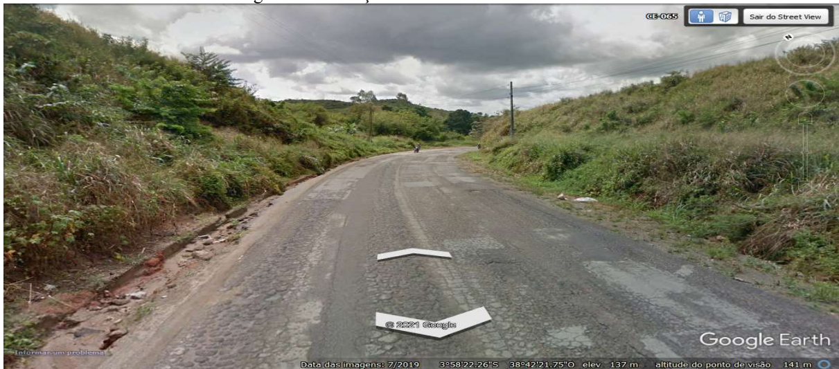
Figura 26 - Situação recente do trecho em estudo
