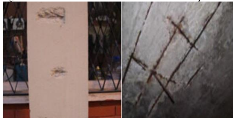
Figura 4 – Corrosão de armadura em elementos de sustentação
