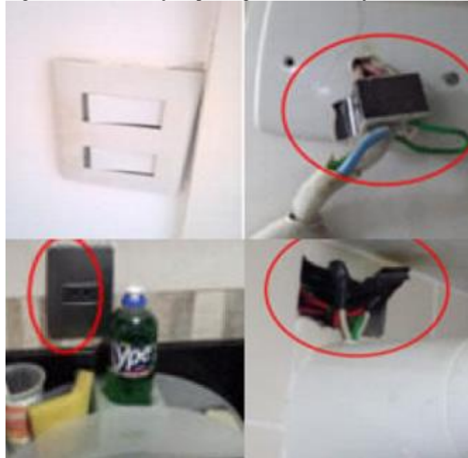
Figura 2 – Manifestações patológicas em instalações elétricas
