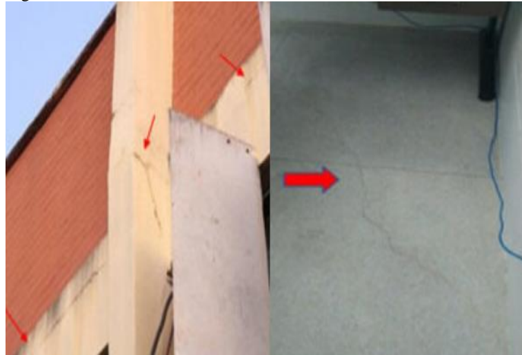
Figura 3 – Fissuras em elementos estruturais
