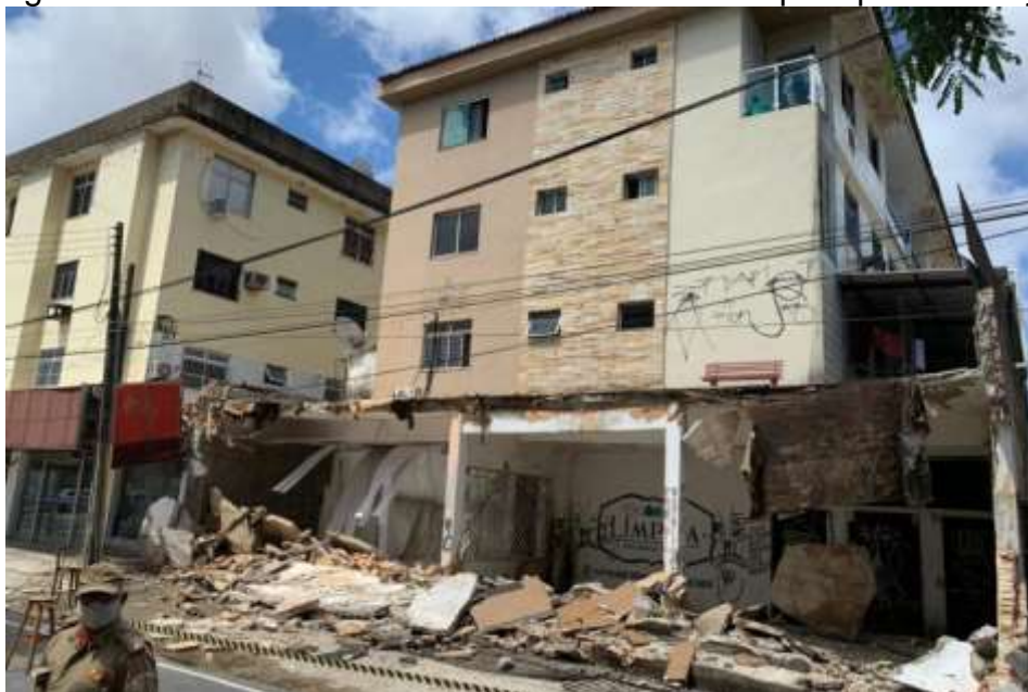
Figura 4 – Fachada do Edifício Solar do Atlântico após queda da laje
