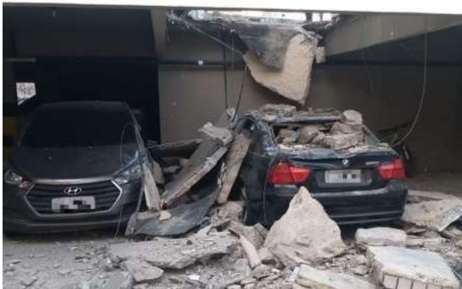
Figura 3 – Garagem do Edifício Salinas após queda de parte da fachada
