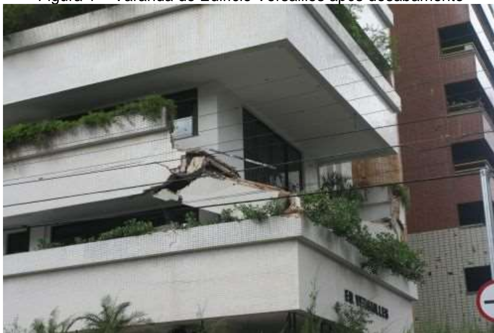
Figura 1 – Varanda do Edifício Versailles após desabamento
