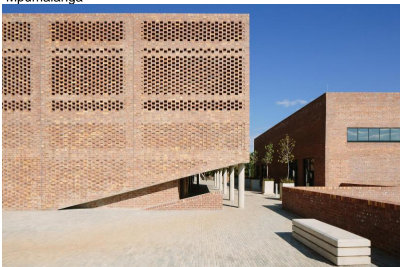
Figura 63: Parede alvenaria moradia estudantil Universidade de Mpumalanga
