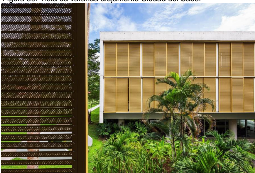
Figura 50: Vista da varanda alojamento Ciudad del Saber
