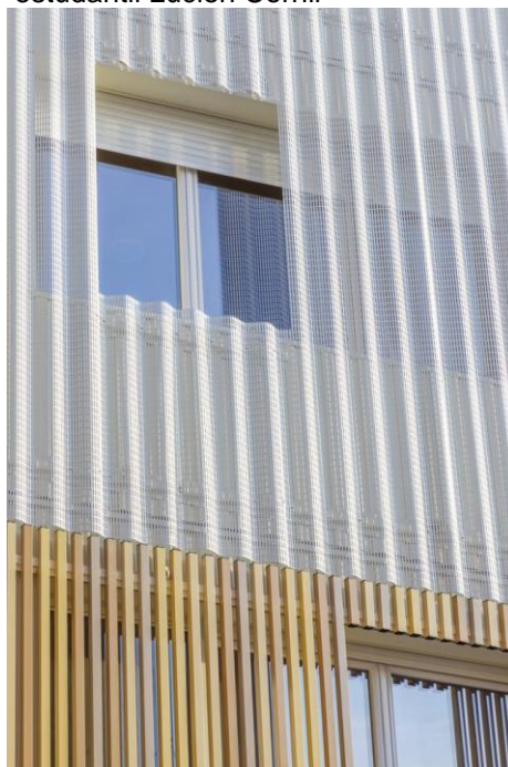
Figura 71: Elementos fachada moradia estudantil Lucien Cornil
