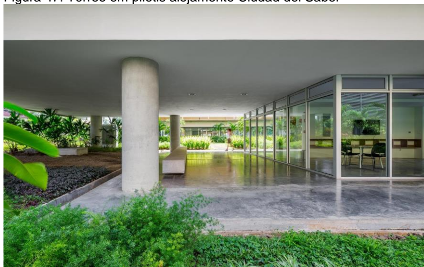
Figura 47: Térreo em pilotis alojamento Ciudad del Saber
