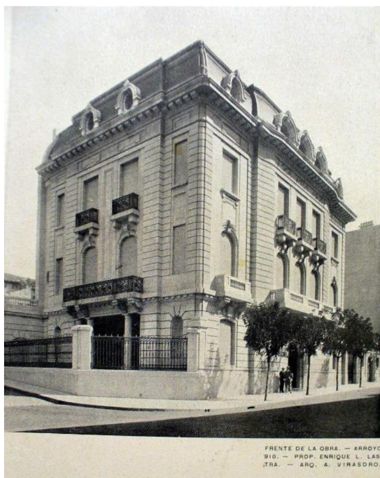
Figura 1: Prédio da Embaixada de Israel antes da demolição.
