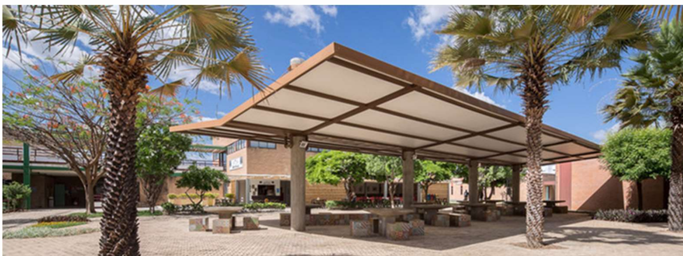
Figura 20: Cobertura borboleta com telhas termoacústicas
