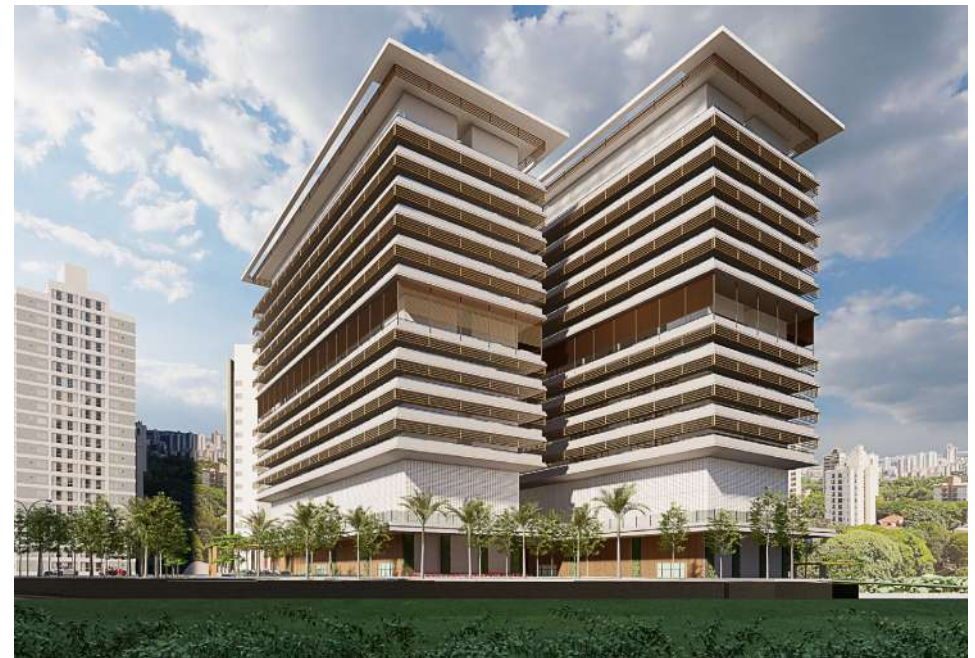
Figura 16 - Materialidade das fachadas.
