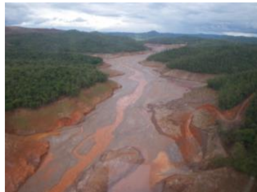
(b) Barragem após o rompimento
