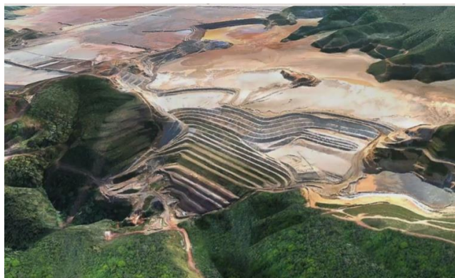
(a) Barragem antes do rompimento
