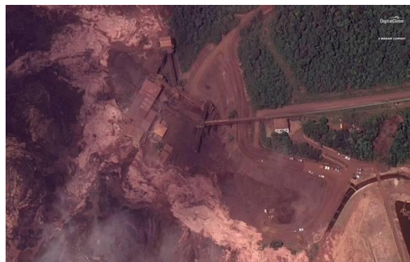
(b) Barragem após o rompimento
