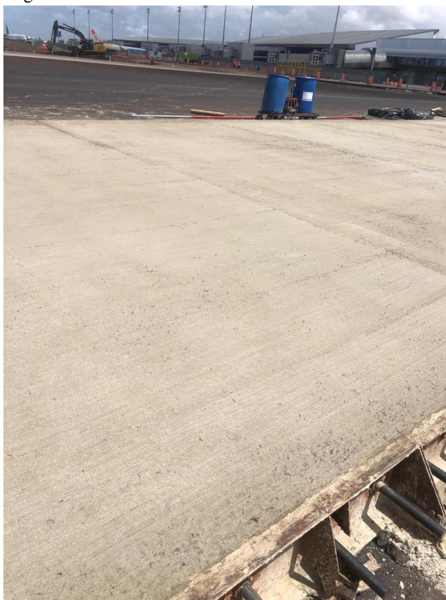
Figura 15 – Pavimento com acabamento vassourado
