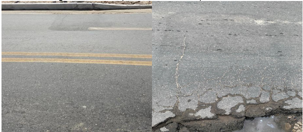
Figura 19 - Antes x Depois - Remendo realizado pela CAGECE.
