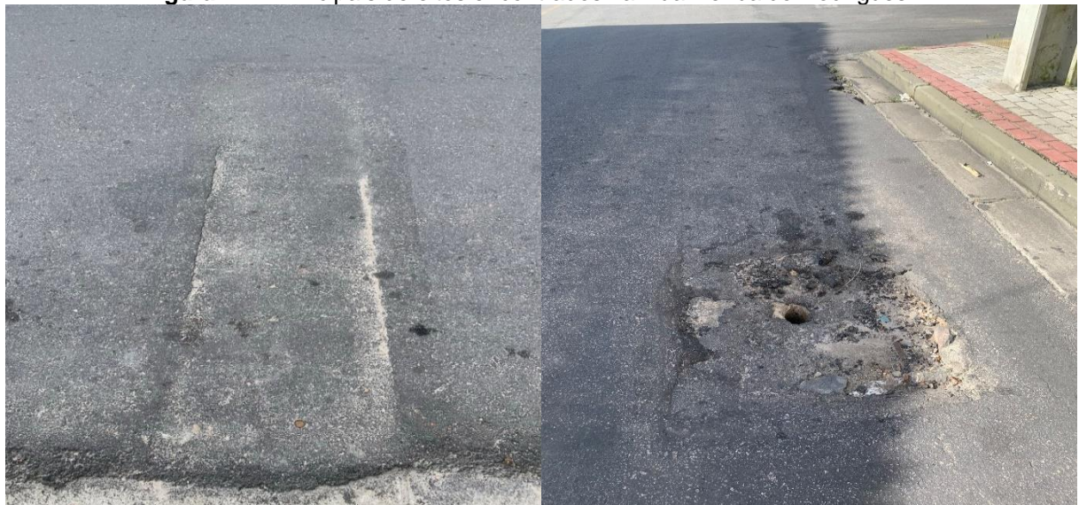
Figura 21 – Principais defeitos encontrados na Rua Heribaldo Rodrigues.
