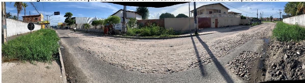
Figura 24 – Execução de remendos em andamento na Av. Juaci Sampaio Pontes.
