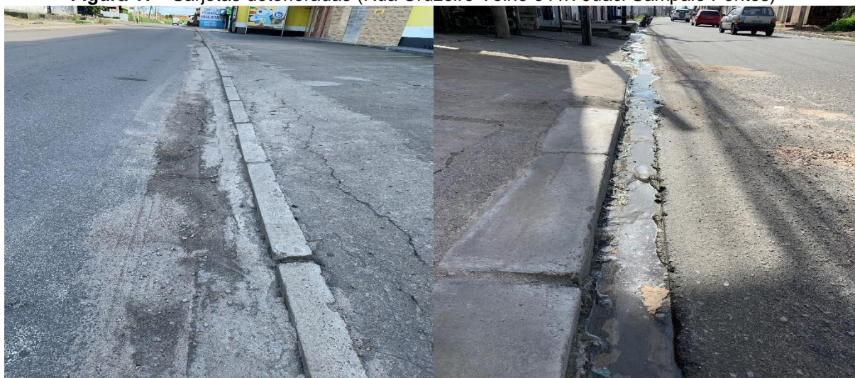
Figura 17 - Sarjetas deterioradas (Rua Cruzeiro Velho e Av. Juaci Sampaio Pontes)
