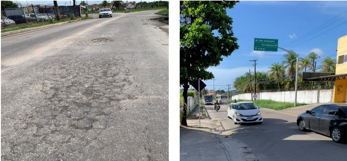
Figura 20 – Trincas Couro de Jacaré e Tráfego intenso na via.
