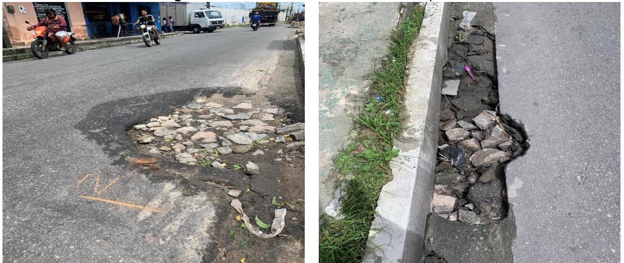
Figura 23 – Painelas encontradas no eixo da pista.
