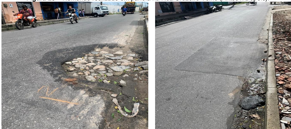
Figura 25 – Remendo realizado em panela na Rua Cruzeiro Velho (Antes x Depois).
