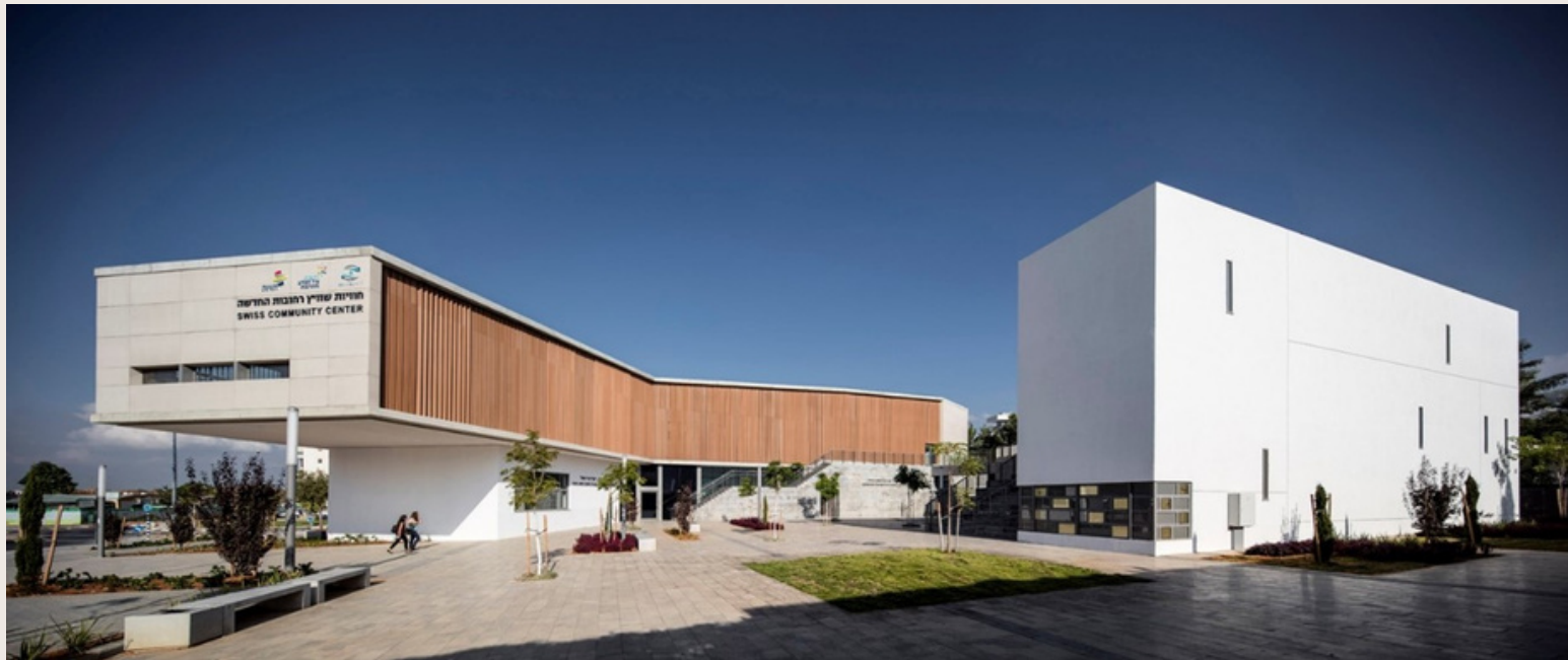
Figura 9 – Centro Comunitário Rehovot.
