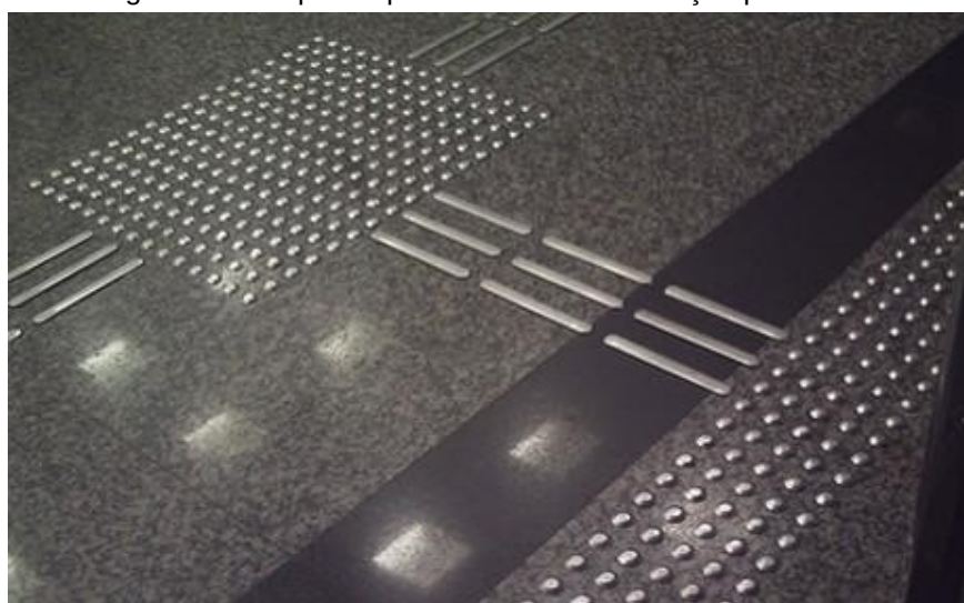
Figura 3: exemplo de piso tátil indicando direção/parada
