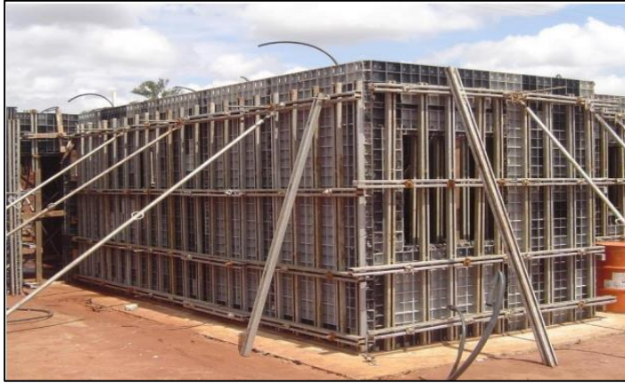
Figura 18 - Fôrma com escoramento
