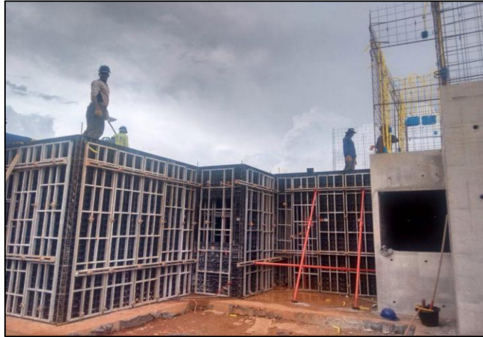
Figura 19 - Fôrmas prontas para o desmolde
