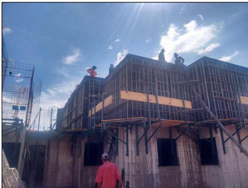
Figura 13 - Levantamento da parede de concreto
