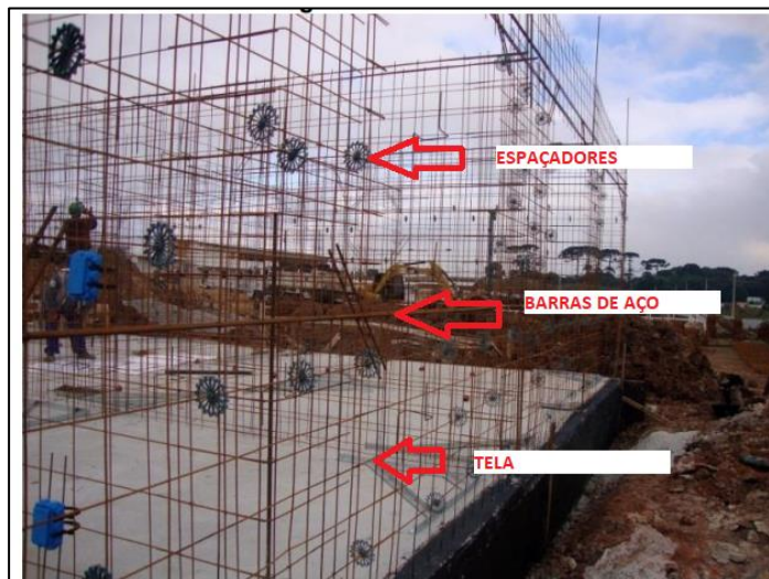
Figura 15 - Armaduras com espaçadores
