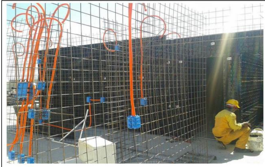
Figura 16 - Instalações na armadura.
