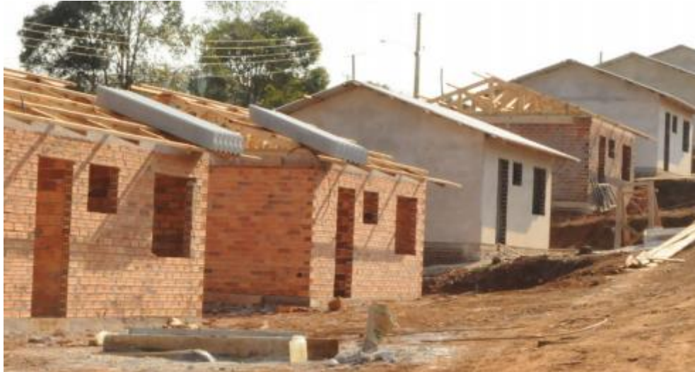
Figura 6 - Sistema Construtivo Convencional
