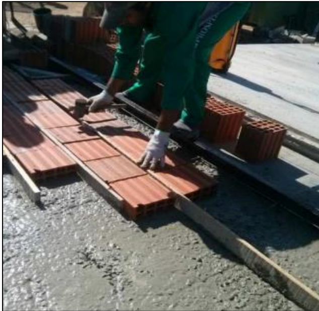
Figura 10 - Colocação de blocos cerâmicos nas formas de montagem
