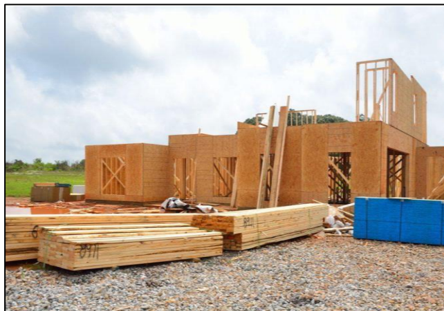
Figura 5 - Sistema Construtivo Wood Frame
