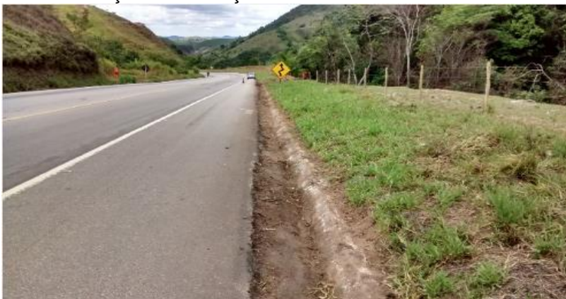
Figura 14 – Sarjetas em condições de utilização
