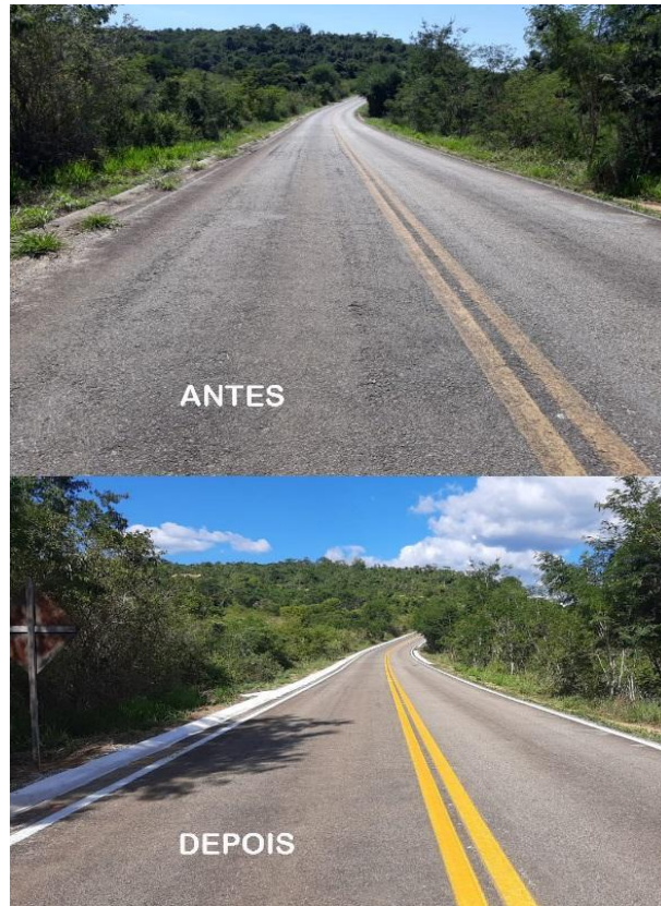
Figura 12 – Sinalização viária horizontal
